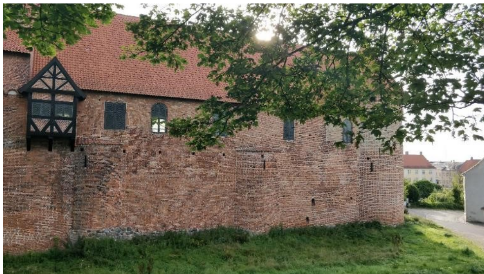
Figur 8-1 Kongefløjen set fra vest, Slotsgade ses til højre i billedet. Foto COWI.
