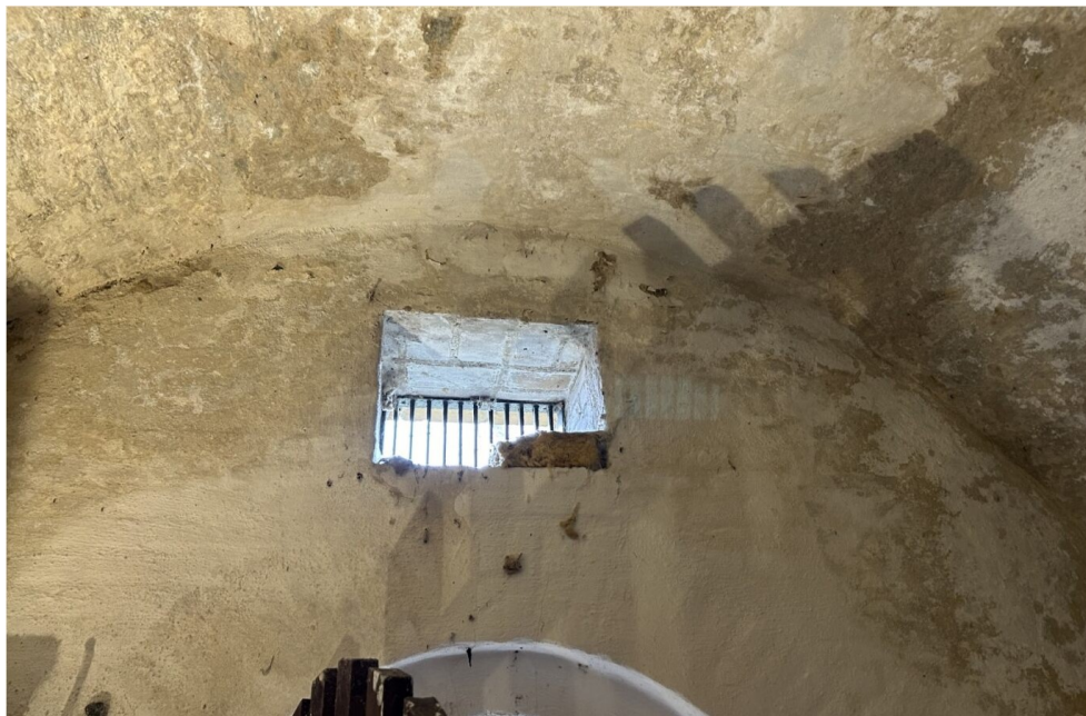
Figur 10-29 Egnede loftshvælvning og åbning der tillader adgang for flagermus i krudtmagasinet på Bastionen.
