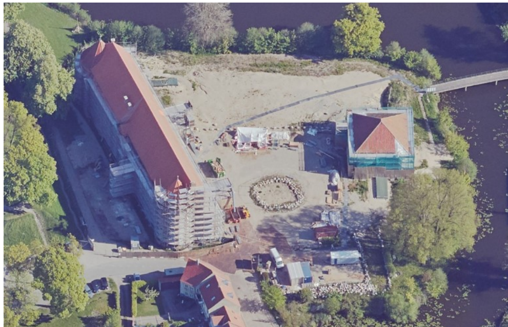
Figur 8-23 Skråfoto fra maj 2019, hvor de arkæologiske undersøgelser er under afslutning. Ved indkørslen fra Slotsgade ses de udlagte køreplader til tungekøretøjer. Mellem Vagttårnet og Kongefløjen ses en række kampesten, der er udlagt som sikring af fortidsminderne i den nordlige del af projektområdet. Kilde: COWI MapViewer
