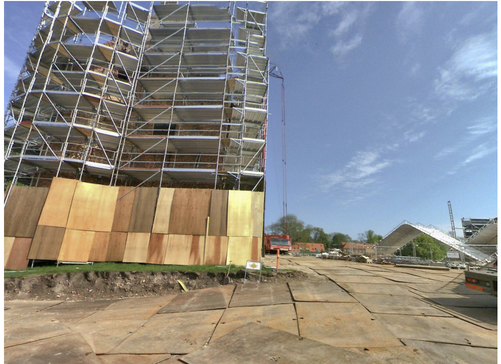
Figur 4-16 Streetview foto af igangværende renoveringsarbejder fra 2018. Kilde: COWI MultiViewer
