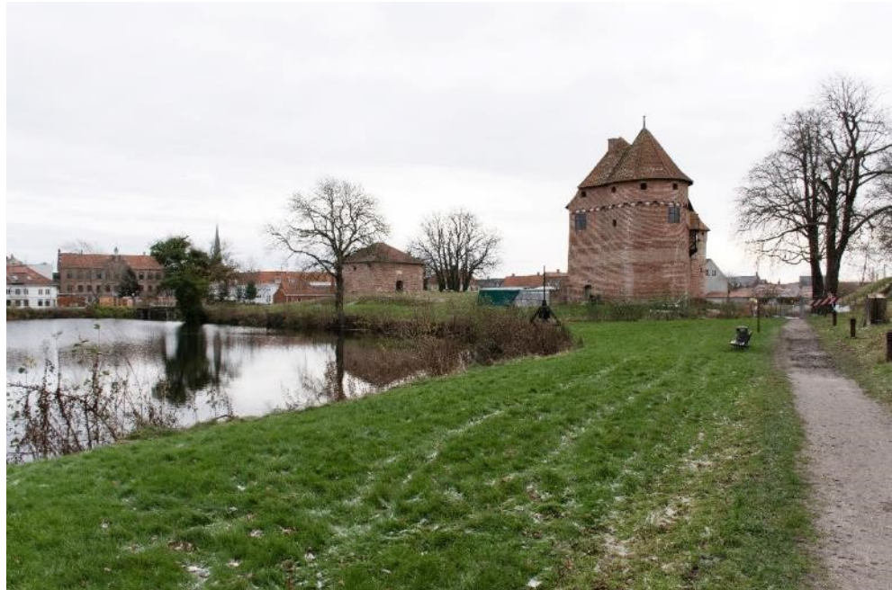
Figur 8-11 Nyborg Slot set fra nord på stien mellem Blegdamsgade og Slotsgade. COWI.
