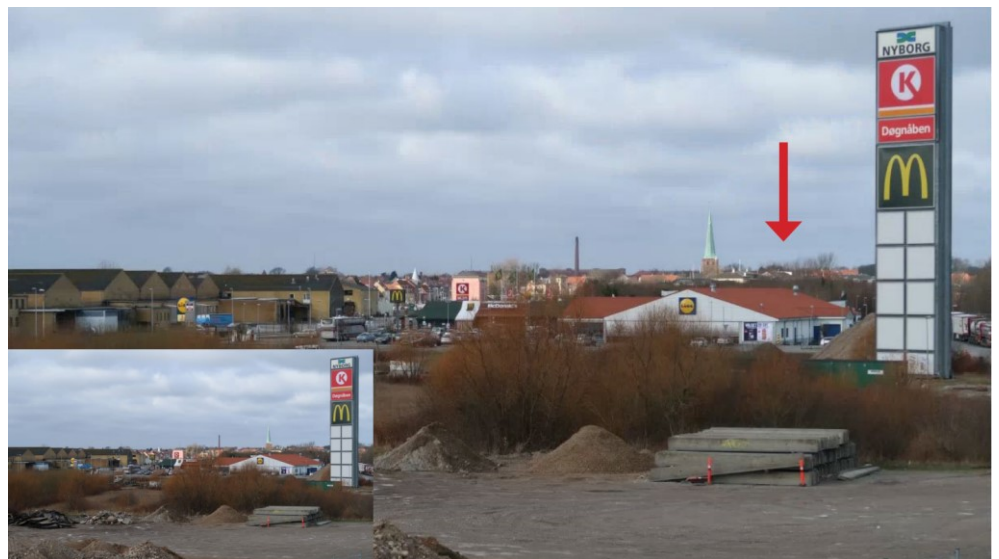
Figur 8-4 Volumenstudie, kig fra Storebæltssvej ved til- og frakørsel til motorvej E20. Nyborgs 'skyline' domineres i dag af Vor Frue kirkes tårn og spir, skorstenen til det gamle gasværk og pylonerne ved motorvejen. Denne visualisering viser det forhøjede Vagttårns indvirkning på Nyborgs 'skyline' set fra broen over motorvejen. Det forhøjede tårn kan netop anes. Tårnet falder dog i høj grad i et med byens tage. Kilde: miljøvurdering af lokalplan nr. 281.
