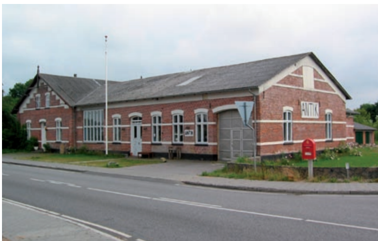
Det tidligere andelsmejeri, der ligger ved den gennemgående Kystvej, udgør en velbevaret helhed. Bygningen mangler i dag skorstenen, men udgør ellers et tidstypisk og velbevaret kompleks med en særlig fin detaljering af murværk.
