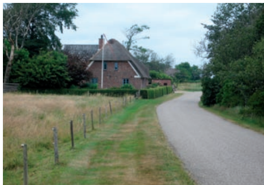
Åkirkevej med sit næsten uændrede forløb siden middelalderen.
