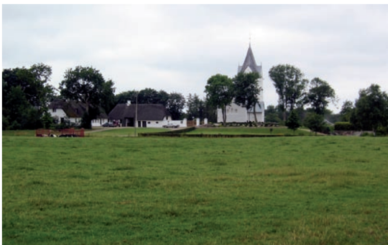
Vester Vedsted Kirke og præstegård er beliggende på byens højeste punkt i et meget fint samspil med den karakteristiske grønning.
