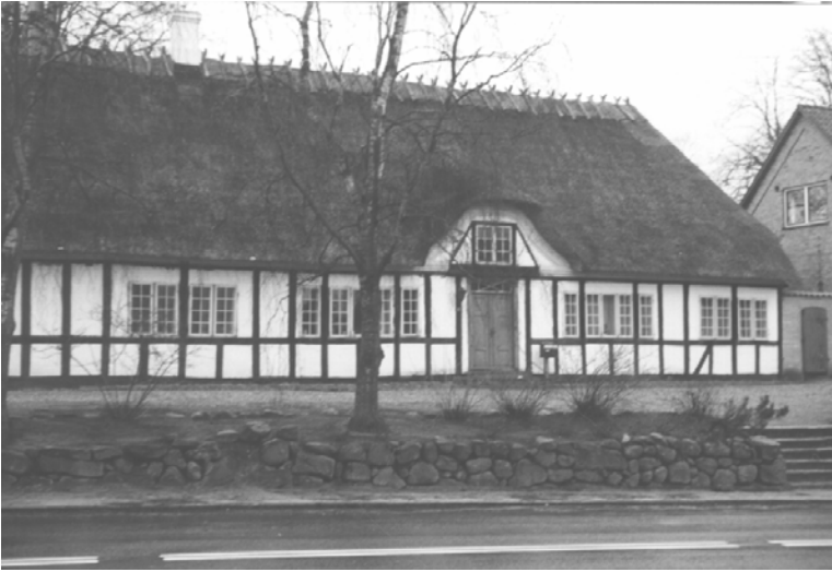
Vester Hæsinge Skole Birkevej 17, Broby Kommune Opført i slutningen af 1800-tallet Fredet 1989
