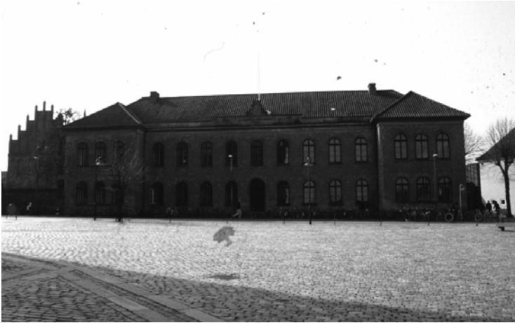
Statsskolen Domkirkepladsen 1, Roskilde by Opført 1842 af J.H. Koch Fredet 1924
