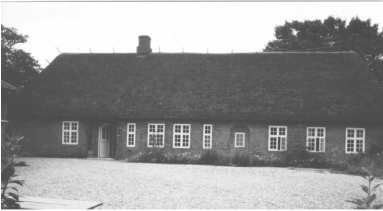
Emmerlev Skole Emmerlevvej 20, Højer Kommune Opført 1857 Fredet 1991
