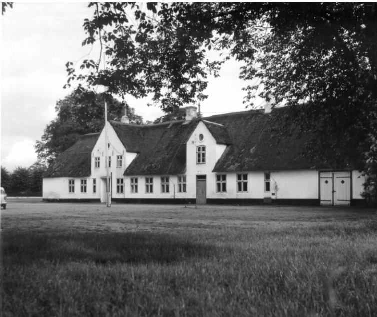
Øster-Højst gamle Skole Kirkevej 2, Løgumkloster Kommune Opført 1844 Fredet 1954
