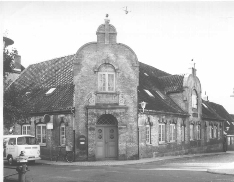
Günderoths Skole Nygade 48, Åbenrå by Opført 1847 Fredet 1971
