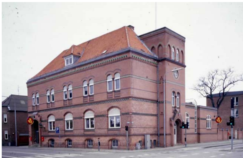
Tønder Posthus, opført af det tyske postvæsen, set fra Kongevej
