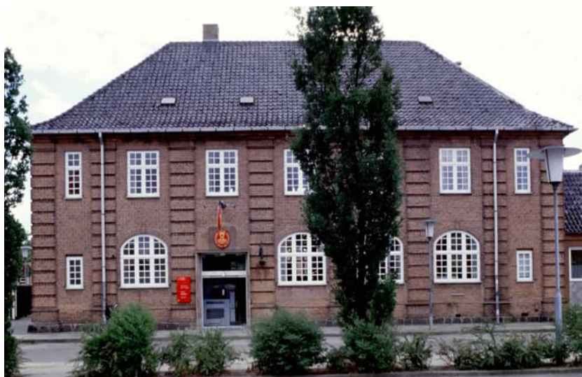
Maribo Posthus med den flyttede indgangsdør, set fra Banegårdspladsen
