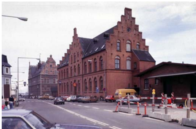
Den nygotiske Helsingør Station fra 1892
