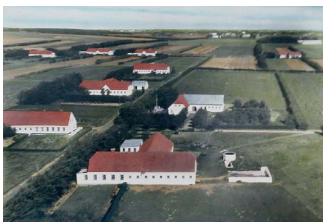
Udsigt over en del af Hjermitselevgård Mark hvor 20 parceller blev udstykket i 1930. Udstykningen bærer præg af en vis påvirkning fra Landsforeningen for Bedre Byggeskik. Det er dog ikke alle steder i disse udstykninger, foreningens ideer har slået igennem, ofte har en lokal murermester i samarbejde med den enkelte husmand tegnet og indrettet efter økonomi og et lokalt kendskab til, hvad der var brug for.
