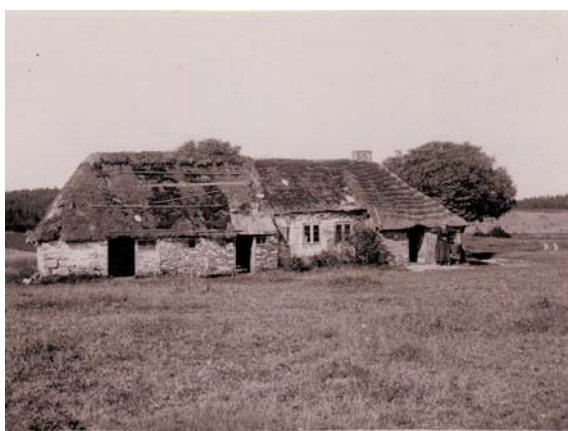
Lyrehus ved Søbeden i Jerslev sogn i Vendsyssel. Murene er opført i en blanding af tilbuggede marksten og teglsten. Taget er af halm og tørv. Foto: K. Mogensen, 1908.
