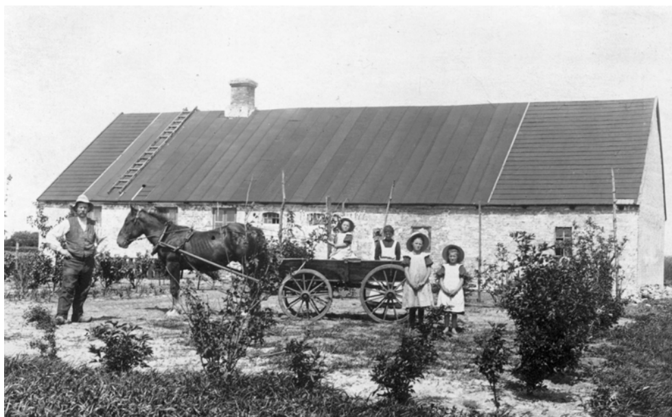
Nybyggerne fra Store Restrup Enge udstykningen i 1890-erne byggede efter behov. Her er det husmand Simon Jørgensen ved sin gård ca. 1910. Taget som oprindeligt har været tækket med spån et i færd med at blive repareret/fornyset med et lag pap.
