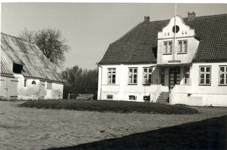
Kaptajnsgården "Ankergrund" i Stollig på Løjt Land, opført 1866.
