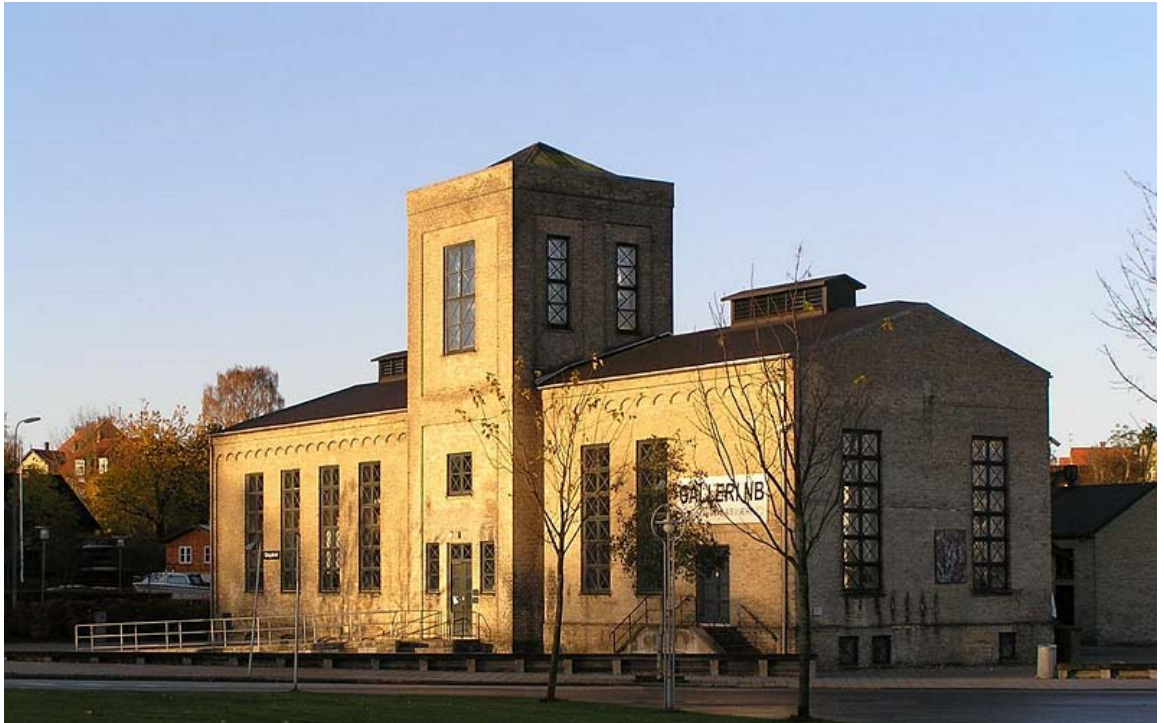
Roskilde Gasværk efter reovering
