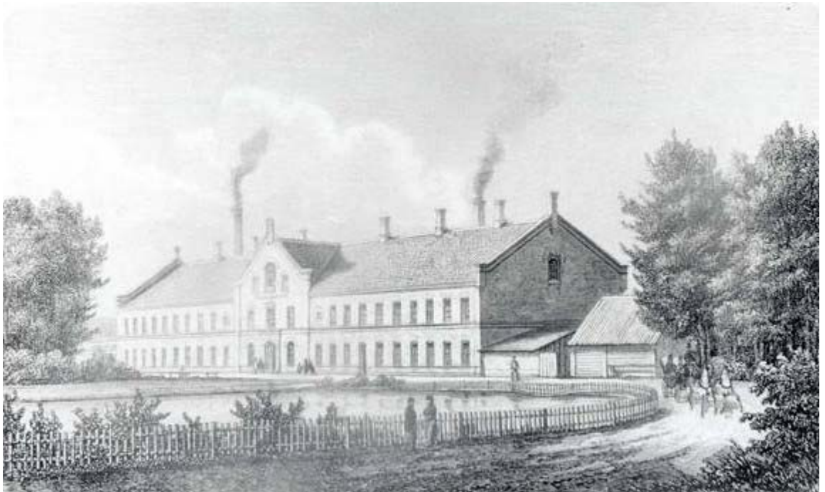
Drewsens gamle hovedbygning fra 1865
