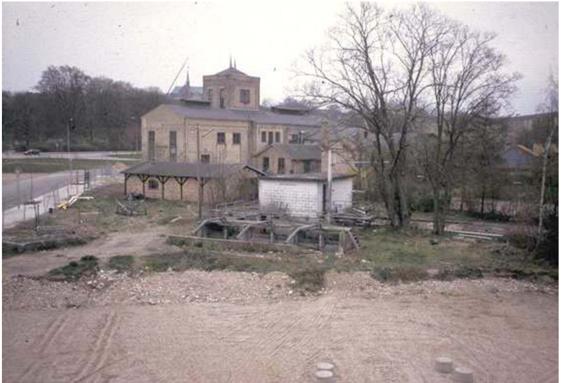
Gasværket efter nedrivningen af rensningsanlægget
