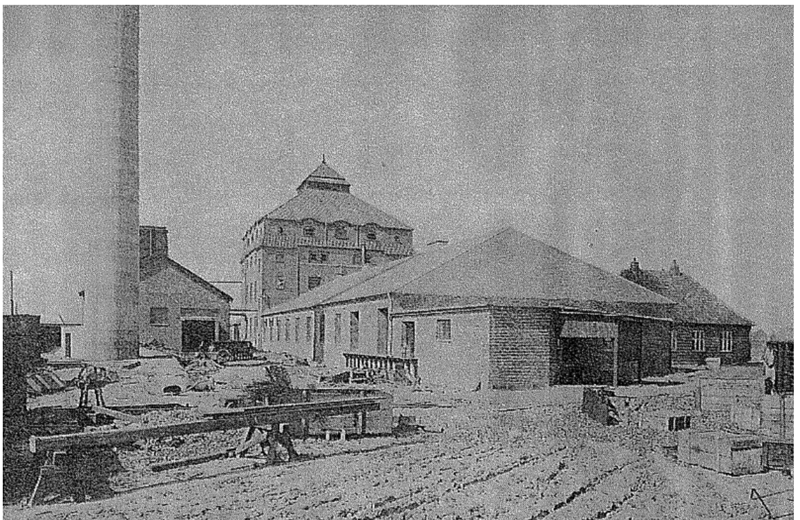
Maskin- og kedelhus med tilhørende skorsten
