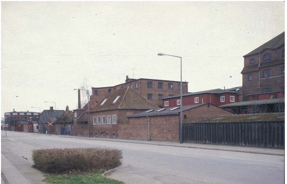
Anlægget set fra Carl Jacobsens Vej med portner og toldbygning
