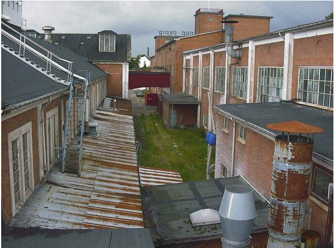
Fabriksanlægget før reovering
