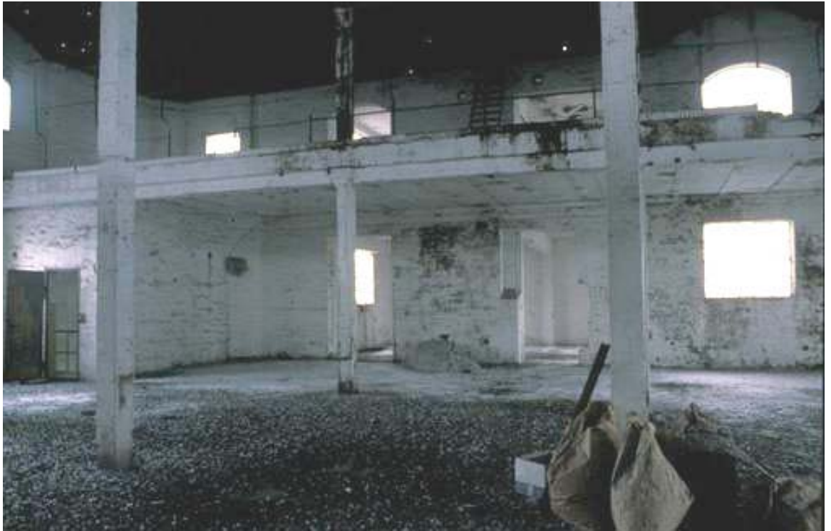
Bygningens indre før reovering
