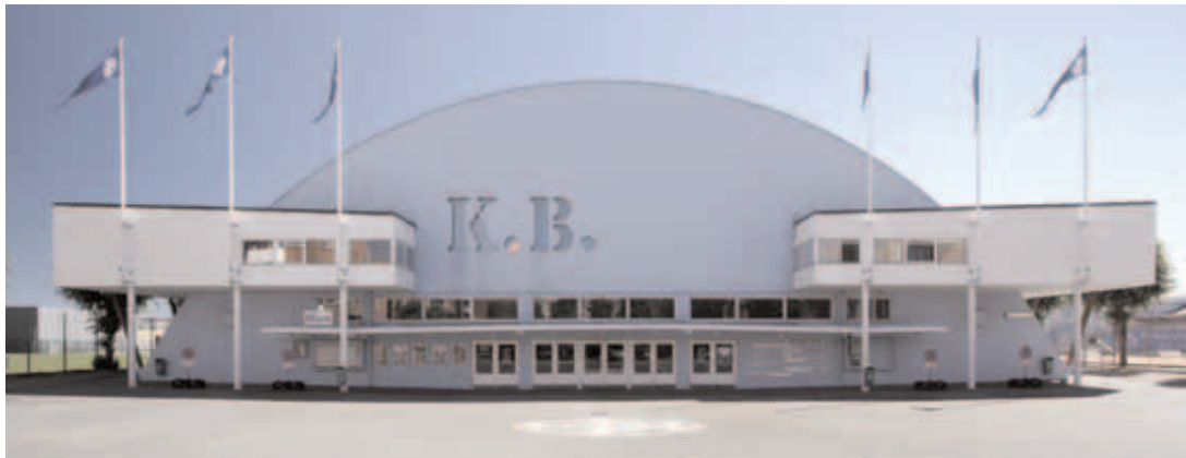
Frederiksberg, Peter Bangsvej, KB Hallen, 1937-38, ingeniør C. Ostenfeld & arkitekt Hans Hansen
