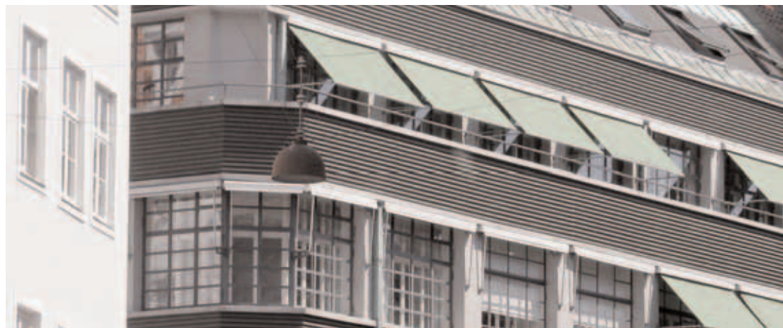
København, Sværtegade/Pilestræde, Berlingske Trykkeri, 1928-30, Bent Helweg-Møller
