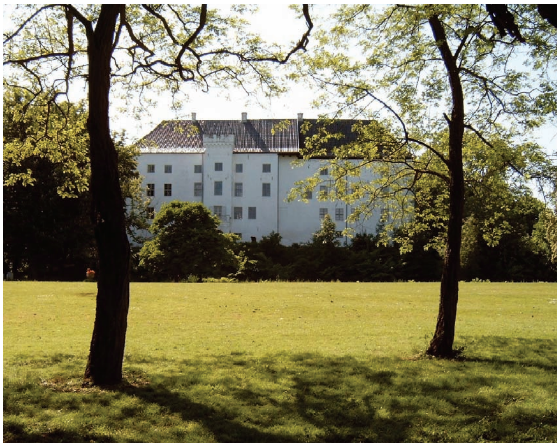
Dragsholm Slot set fra øst. Foto: Arkitekt Stig Løcke
