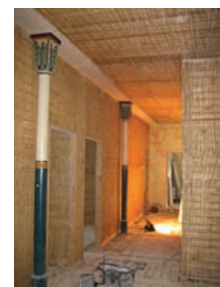
Th.: Facade mod Lille Gråbrødrestrede. Herunder: Indre vægge, der er forberedt til at pudse på rør. Foto: Harrebeks Tegnestue
