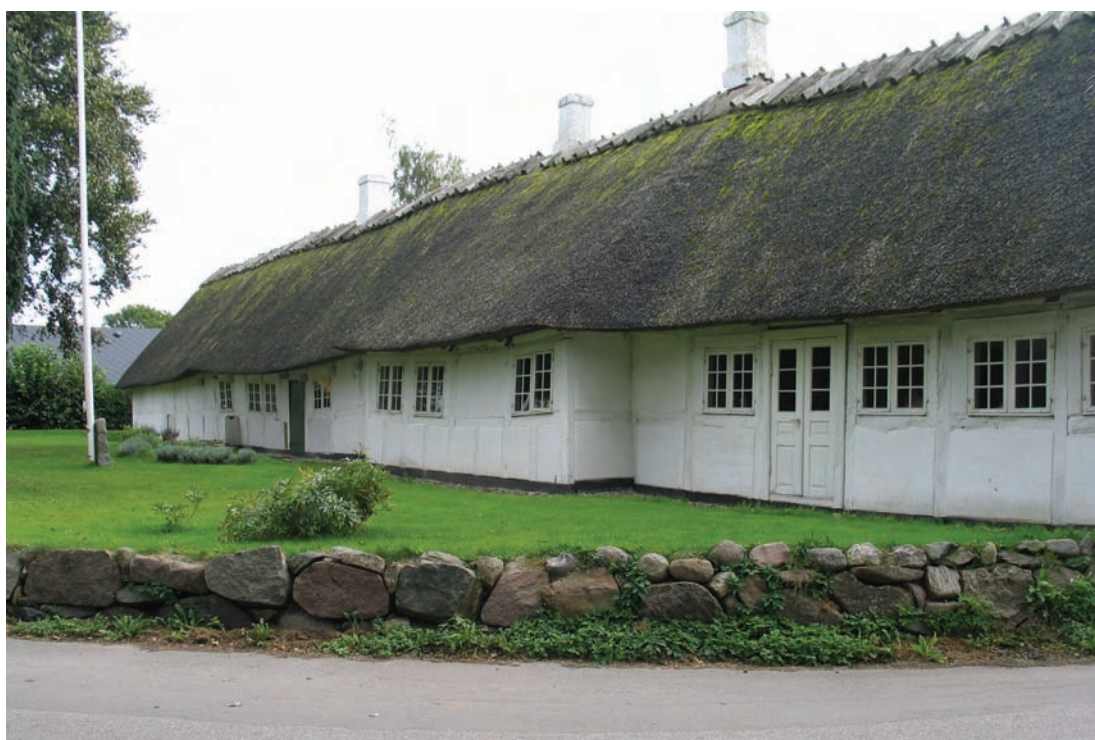
Sognefogedgården, Viby Bygade 12, set fra haveside med de to brønde, der nu også indgår i fredningen.
