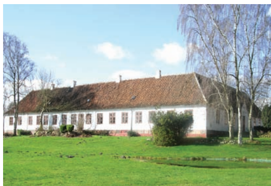
Wedelslund set fra havesiden. Puds og fronton fjernes i forbindelse med den igangværende restaurering.
