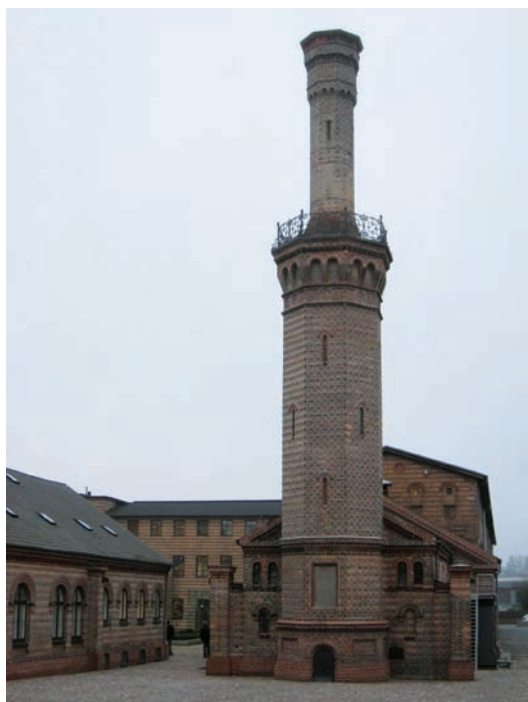
Bastians vartegn den høje dekorative skorsten ved maskin- og kedelhuset fra 1875 af Jens Chr. Clausen.
