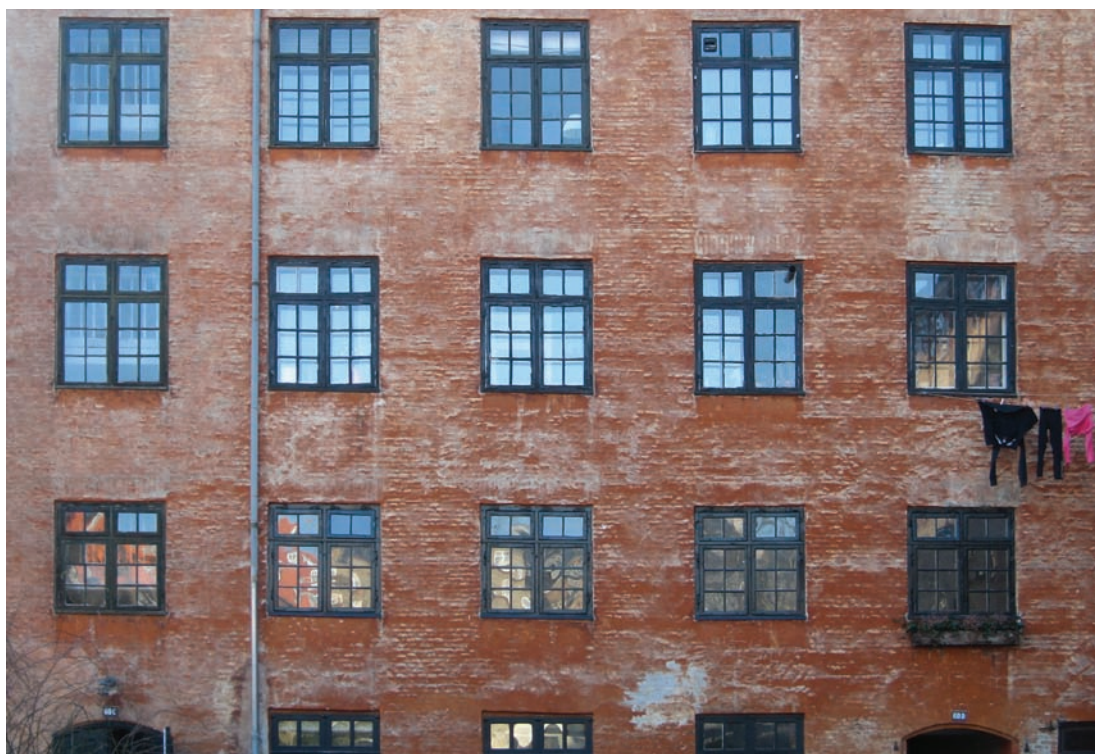
Oprindelige vinduer mod gården i den tidligere Wildersgade Kaserne.
