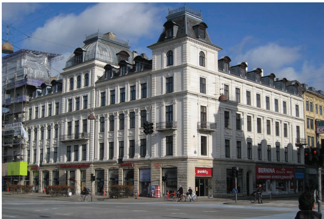
Søtorvet 2, efter størstedelen af arbejderne er gennemført og stilladset på vej ned igen.
