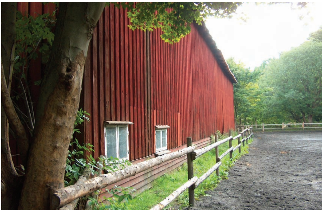
Den røde lade. Foto: Raadvad Center for Bygningsbevaring.
