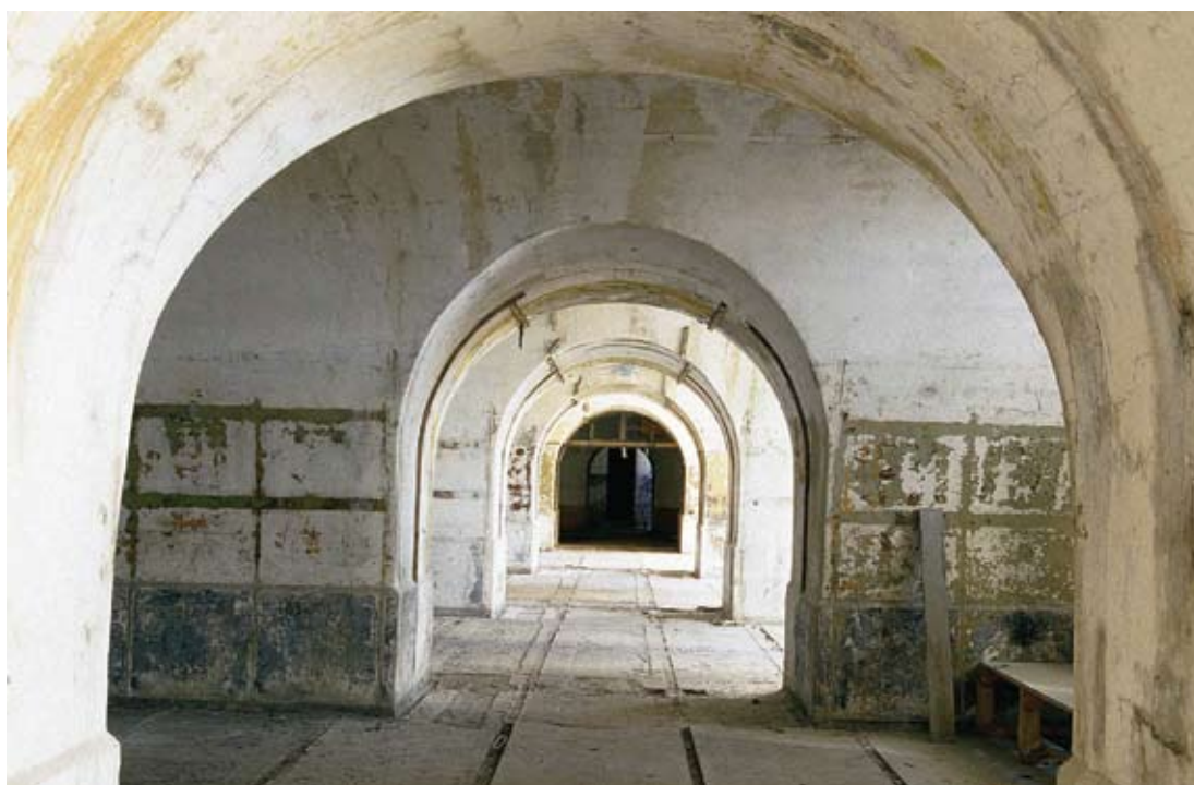
De hvælvede lofter i kasematbygningen.
