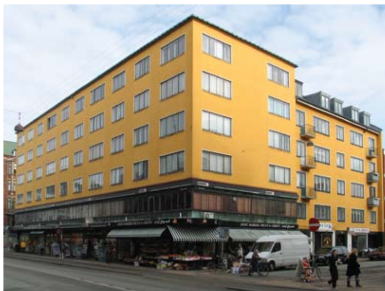
Zøllnerhus med den let tilbagetrukne, kobberbeklædte underetage og terrasse i baggården.
