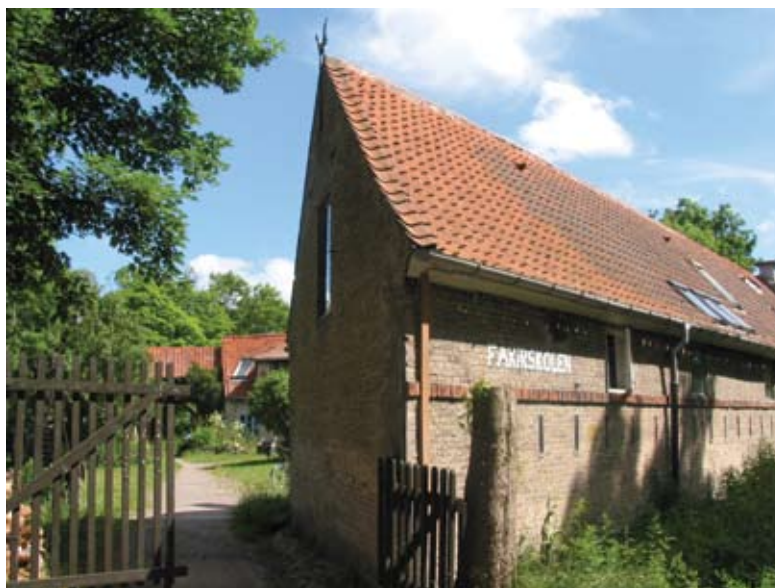
Krudthuset i 4. Redan.
