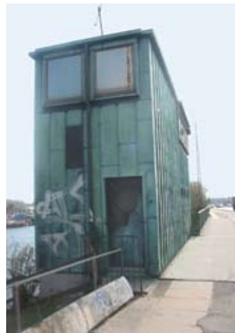
Manøvrehuset på Sjællandsbroen.
