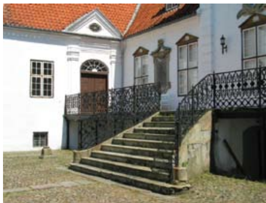
Balkon, trape og jerngitter før restaureringen påbegyndtes. Foto: Erik Einar Holms Tegnstue
