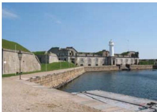
Trekroner Fortets kasematbygning og fyrtårn.
