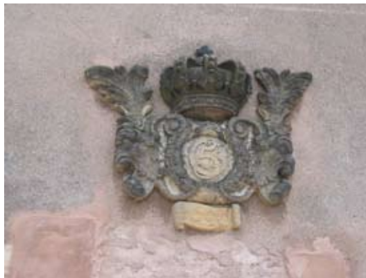
Krudthuset på Carls Bastion er en værdig repræsentant for 1600-tallets militærarkitektur.
