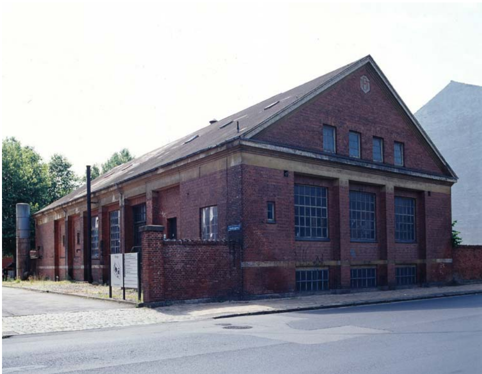
Thomas B. Thriges Kraftvarmeværk i Odense
