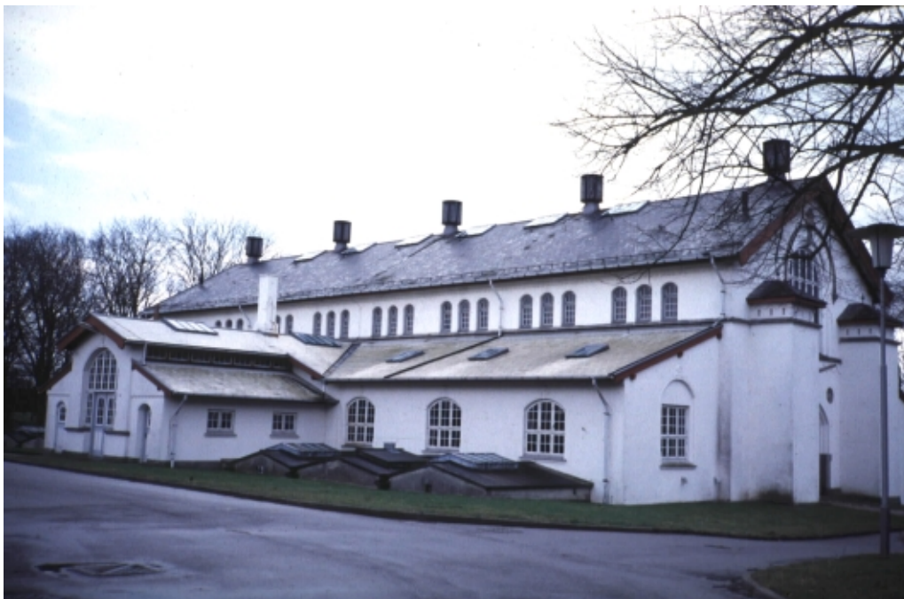
Maskinhuset på Thorsbro Vandværk
