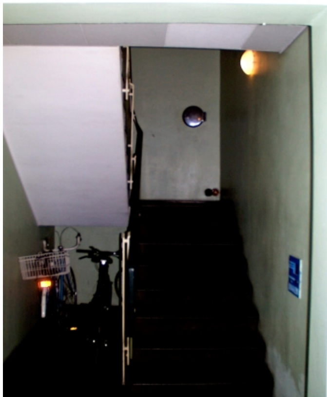
Det ombyggede trapperum i Badstuestræde, København
