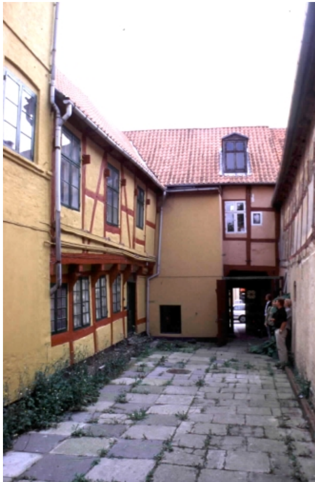
Baggården med det tilbyggede trappetårn i Brogade 14, Køge
