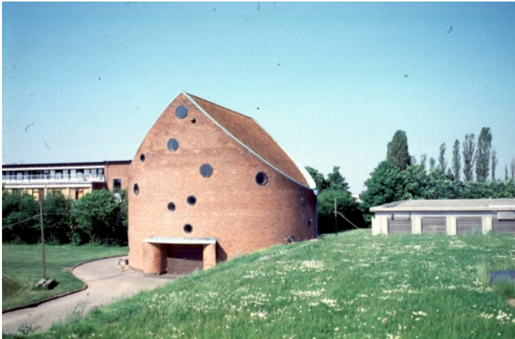
Ventilbygningen på Tinghøj Vandreservoir, Gladsaxe
