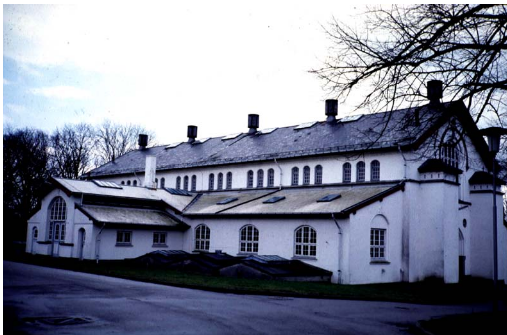
Maskinhuset på Thorsbro Vandværk, Ishøj
