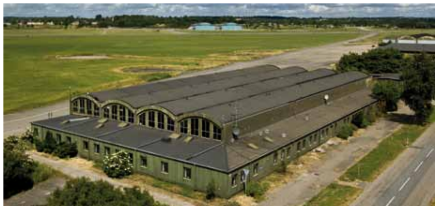
Eskadrillehangar fra Flyvestation Værløse.
