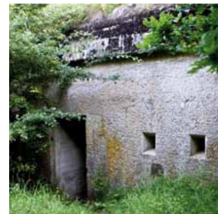
Indgang til betonbunker.
