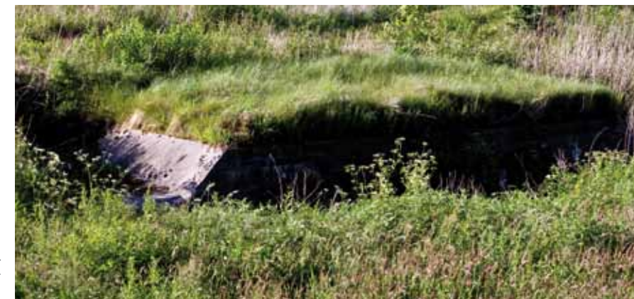
Sprængt bunker ved Sikringsstilling Nord.
