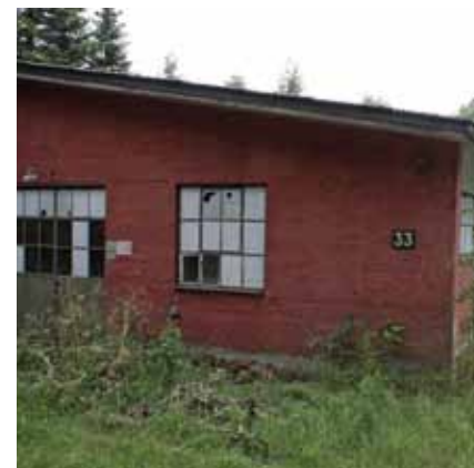
Overflødigt og klar til nedrivning.
