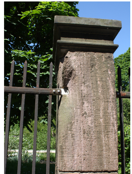
Rustsprængning af indmuret jern i sandsten. Foto: Anne Lindegaard
