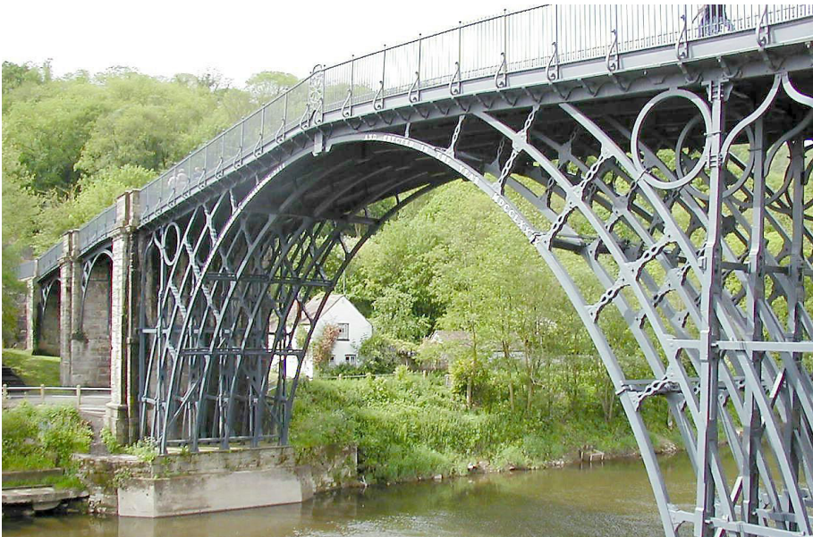
Støbejernsbroen 'Ironbridge' i Wales, er opført i 1777, og har derfor foreløbig holdt i 235 år.
