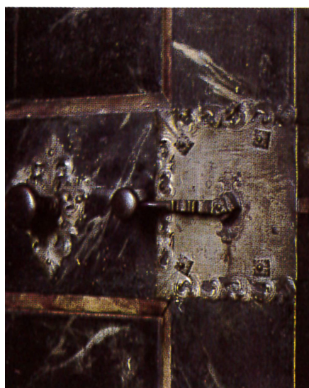
Renæssance-lås fra Frederiksborg Slot, rustbehandlet med fortinning.
