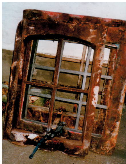
Rustne støbejernstagvinduer, der skal afrensnes og rustbehandles
