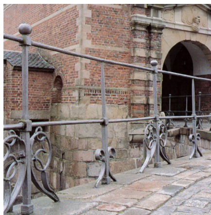
Smedejernsrækværk på S-broen på Frederiksborg Slot, rustbehandlet med blymønje og overfladebehandlet med grafit.
