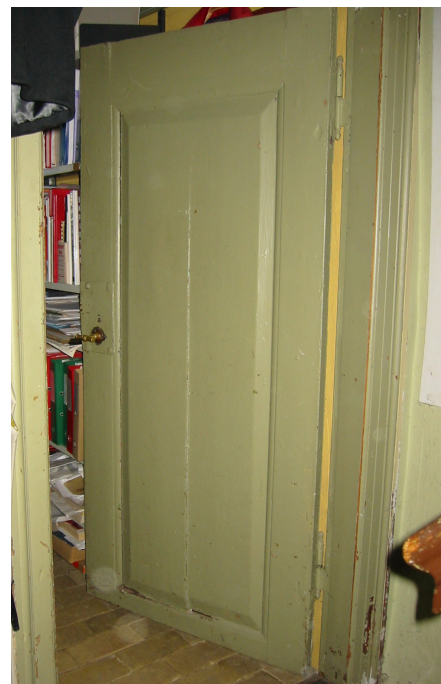
Barokdør med stor fyldning. Fyldningen er revnet i midten og døren er desuden kraftigt afkortet i underkanten, formentlig fordi gulvet på et tidspunkt er hævet.
