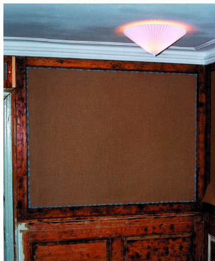
Opspænding af væglærreder af jutevæv udføres stadig af kompetente malere. Efter opspændingen skal lærredet krideres og limfarves.
