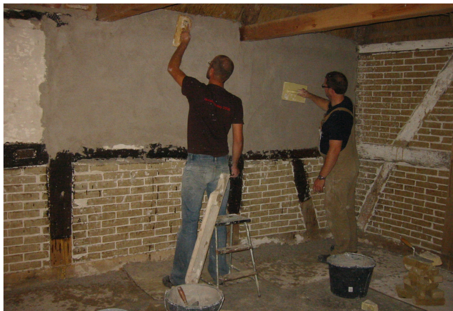
Pudsning af overvægge i et bindingsværkshus. Der er slået kyllingenet på tømmeret, for at pudsningen skal hænge fast på dette. Der puds med en ren luftkalkmørtel.
