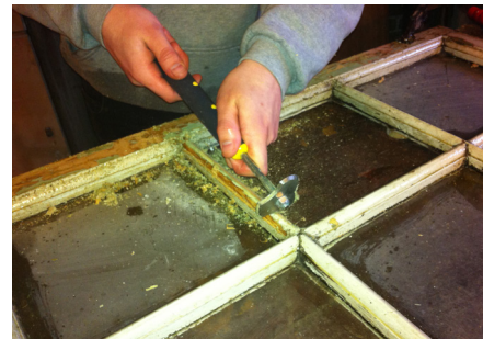
Vådafskrabning, uden varme. Linolien blødgør og løsner de gamle, løse malingslag. Herefter skrubes der med en hårdmetalskraber.
