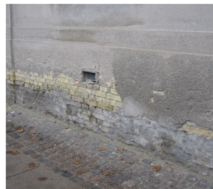
De optagne mursalte i murværket vil ved bestemte lufttryk og temperaturer udkrystallisere på overfladen af murværket eller lige under denne. Under udkrystalliseringen udvider saltene sig ca. 10 gange deres størrelse fra flydende til fast form. Hvis dette sker mange gange, sprænges og pulveriseres både puds, mursten og fuger.
