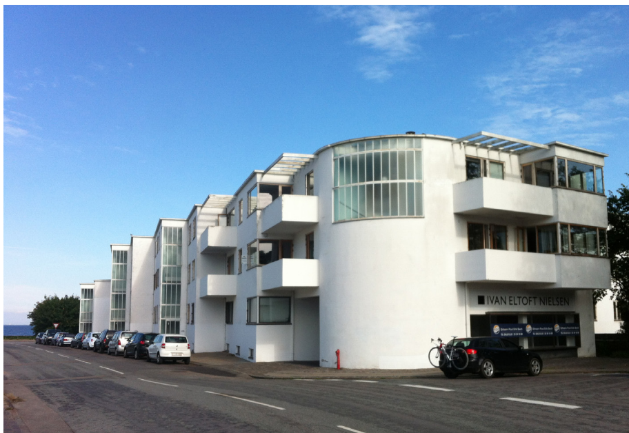
Den såkaldt 'hvide' internationale funktionalisme (1930-1940) har oprindeligt været kalket med hvidtekalk, og burde kalkes igen, da det er hvidere og teknisk bedre end plasticmaling eller silikatmaling. Bellavista i Klampenborg.
