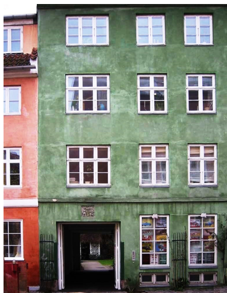
Københavnske 'Ildebrandshuse' – her er vi oppe ved den tredje bybrand i 1807 – har ikke oprindeligt været pudset med farvet puds, men kalket i kraftige farver. Man ville derfor opnå et smukkere, mere holdbart og ensartet resultat, og ikke så ru i overfladen, hvis man kalkede med samme farve oven på den farvede puds.
