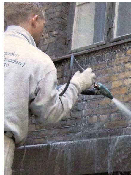
Lavtrykssandblæsning med JOS-metoden.
