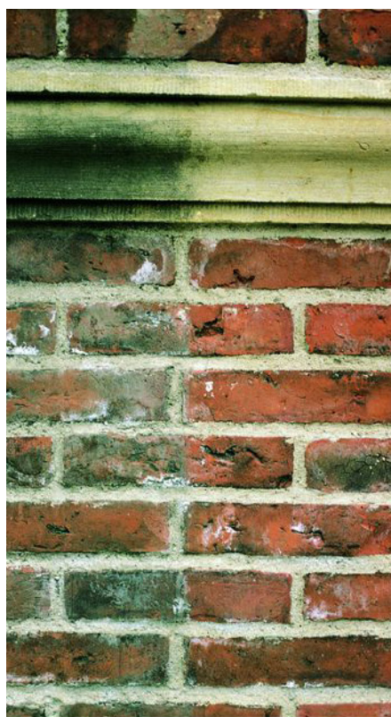
Her er der afsat en prøve på afrensninger, der viser, hvor nænsom, den skal være, og at der ikke må opstå misfarvninger af sandsten, mursten eller fuger.
