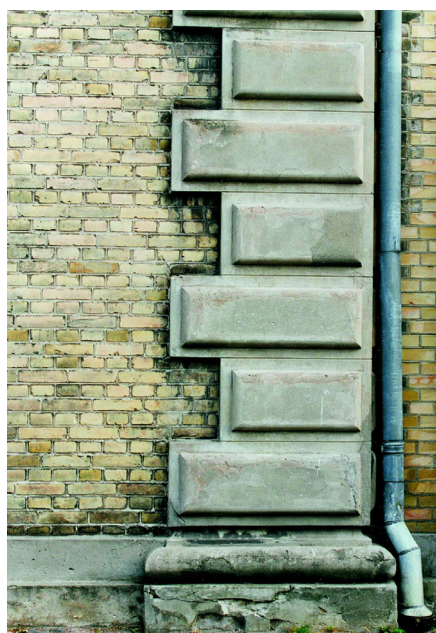
Hus med kvaderhjørne, støbt i Portlandcement. Det snavs, der har lagt sig i de ikke-vandskyllede 'skygger' under kvadrenes fremspring er med til at understrege facadedekorationens karakter. Det ville være synd at afrense disse.
