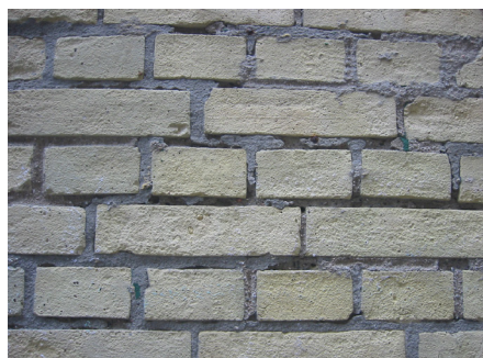
Typisk sandblæst facade, hvor både murstenene og fugerne er kraftigt skadede af for hård behandling. Stenene vil efterfølgende snarere falde af end blive til.
