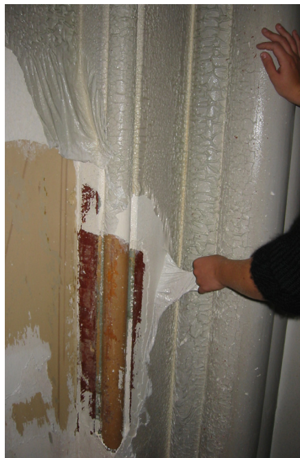
Kemisk afrensning af plastikmaling kan være ret effektiv, så plasticmalingen nærmest kan trækkes af.
