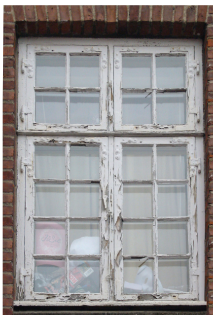
Meget slemt afskallet plast- eller akrylmalet vindue, kan også være vandig alkyd eller plastalkyd, der stort set er det samme.
