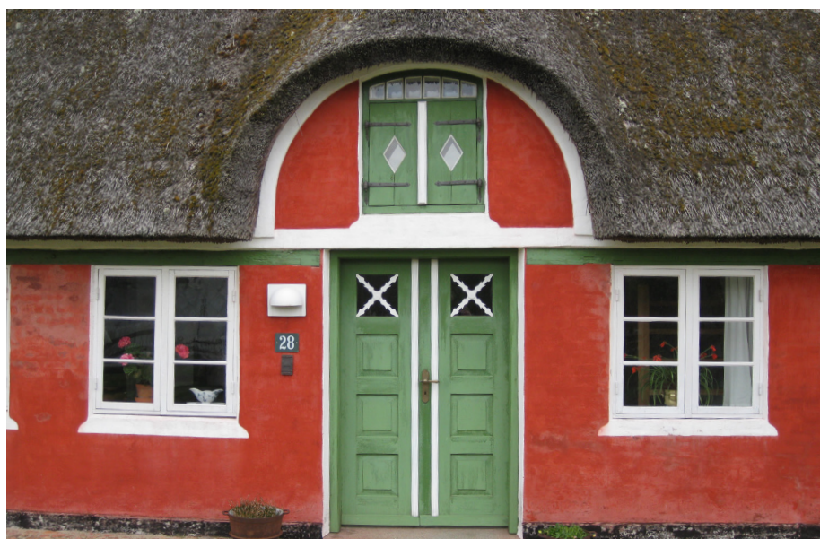
Et yderligere aspekt ved alt bygningsmalerarbejde er de forskellige malingstypers og farvers arkitektoniske udtryk. Det skal passe sammen med husets arkitektur, dets alder og det bygningsmiljø, huset befinder sig i.
