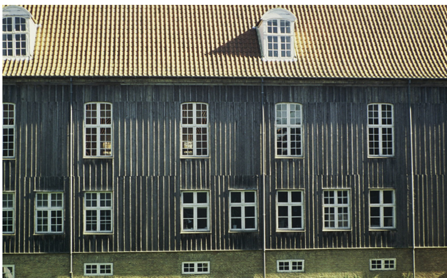
Søstrehuset i Christiansfeldt opført 1776 er på den udsatte nordside og på vestgavlen beklædt med brædder – sat uden på det grundmurede hus. Med træ i god kvalitet, godt ventileret og anbragt konstruktivt korrekt som her kan træbeklædninger holde i hundreder af år i Danmark.
