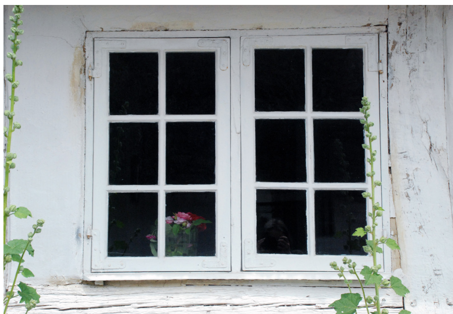
Vindue af fyrretræ fra ca. 1790. Når man ser hvor ringe holdbarhed moderne vinduer af træ, plastik eller aluminium har, i forhold til dette, er der god grund til dels at passe godt på de gamle, originale vinduer, ved at vedligeholde dem med de rigtige materialer, dels at studere, hvad der adskiller dem, rent træteknisk og materialemæssigt fra den måde, man benytter træ på i dag.
