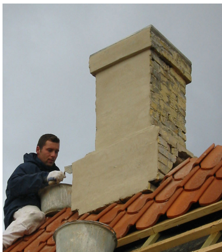
Systemet i en muret inddækning på en skorstenspipe er, at den udkragede sokkel på pipen giver plads til et kraftigt indhak, hvor tagstenenes ender kan lægges ind og fuges ud med mørtel. Det er en smuk, naturlig og også billigere løsning end zinkinddækning
