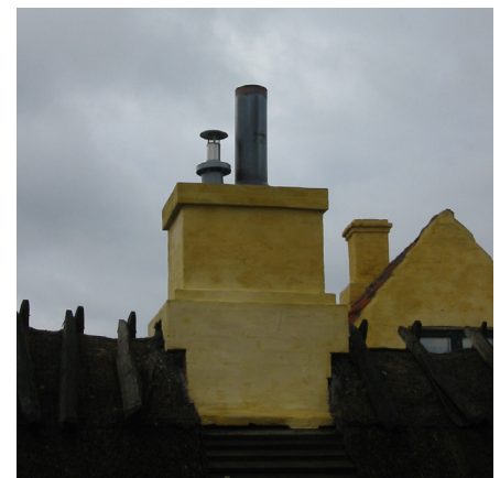
Det er jo fint, at husets skorsten stadigvæk kan bruges, men disse gevækster, foranlediget af et naturgasfyr, pynter ikke ligefrem. I Dag kan man installere naturgasfyr uden at dette er nødvendigt.
