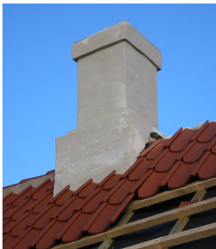
Systemet i en muret inddækning på en skorstenspipe er, at den udkragede sokkel på pipen giver plads til et kraftigt indhak, hvor tagstenenes ender kan lægges ind og fuges ud med mørtel. Det er en smuk, naturlig og også billigere løsning end zinkinddækning
