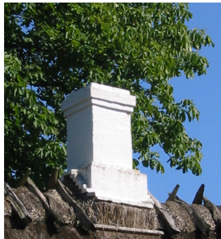
Skorstenspipe, hvor tilslutning mod tag er udført med musetrappe.
