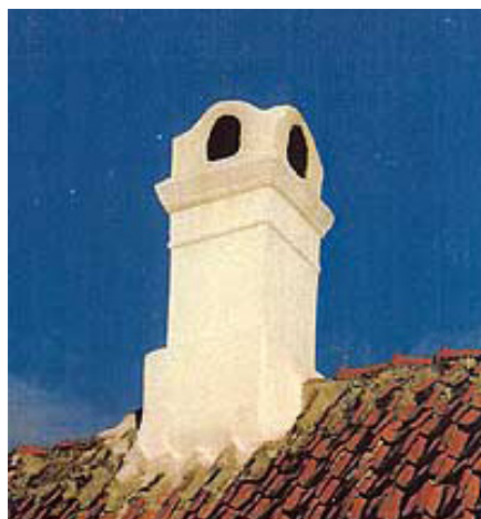
Skorstenspibe med afdækning fra Dragør.
