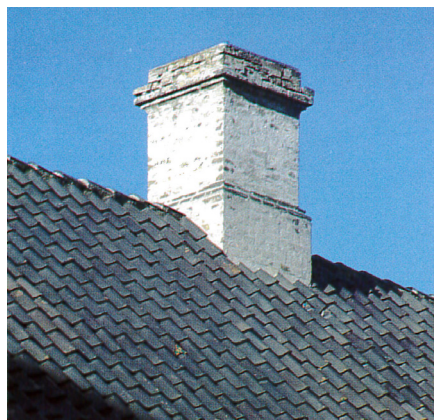
Systemet i en muret inddækning på en skorstenspibe er, at den udkragede sokkel på piben giver plads til et kraftigt indhak, hvor tagstenenes ender kan lægges ind og fuges ud med mørtel. Det er en smuk, naturlig og også billigere løsning end zinkinddækning
