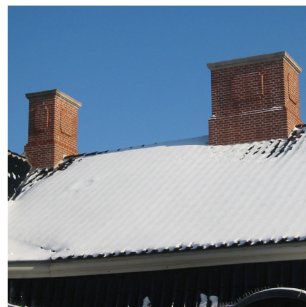
T.v. Pragtskorsten på Dehns Palæ, opført 1754. Skønt piben ikke kan ses fra gaden har den pyntebånd og blændinger, samt naturligvis udkræget gesims og sokkel. T.h. Pragtskorsten på Barchmanns Palæ. Her er gesimsen udført i sandsten og i stedet for en blænding er det er spejl (lille udkræget murfelt) på skaflet.
