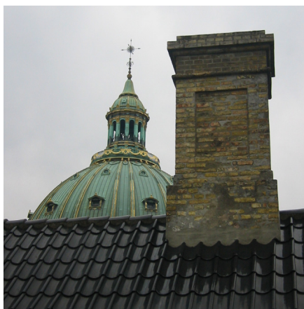
T.v. Pragtskorsten på Dehns Palæ, opført 1754. Skønt piben ikke kan ses fra gaden har den pyntebånd og blændinger, samt naturligvis udkræget gesims og sokkel. T.h. Pragtskorsten på Barchmanns Palæ. Her er gesimsen udført i sandsten og i stedet for en blænding er det er spejl (lille udkræget murfelt) på skaflet.
