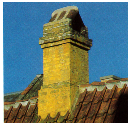
Systemet i en muret inddækning på en skorstenspibe er, at den udkragede sokkel på piben giver plads til et kraftigt indhak, hvor tagstenenes ender kan lægges ind og fuges ud med mørtel. Det er en smuk, naturlig og også billigere løsning end zinkinddækning
