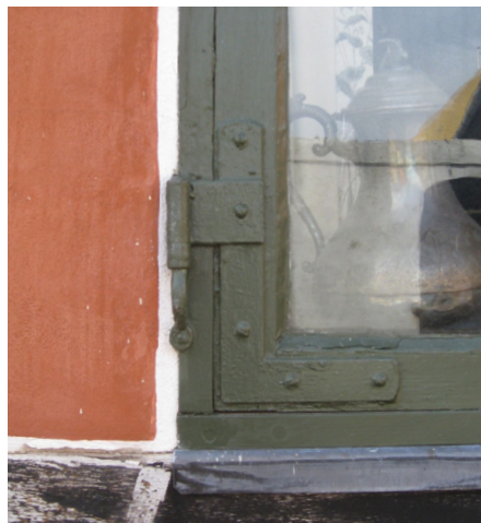
Typisk dansk hjørnebåndshængsel fra efter 1850. De gamle jernbeslag ser tit slemme ud med tykke malingslag, rustskader etc.; men de er ikke uoverkommelige at sætte i stand.
