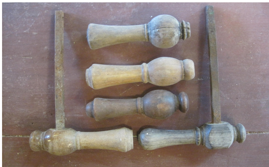
Drejede dørgreb med knebelfacon. Det ses, at de er individuelt drejede og derfor ikke helt ens.
