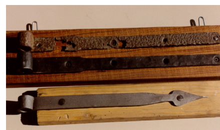
Forskellige båndhængsler til porte. Øverst det gamle forvitrede beslag, og under dette nysmedede kopier.
