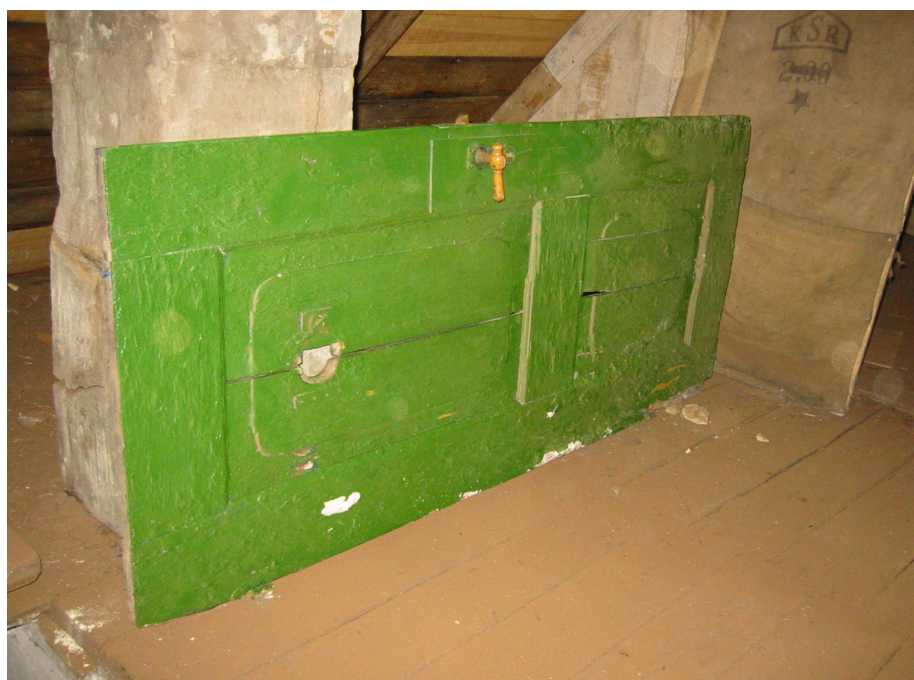
En gammel dør, der ligger på loftet kan dateres ud fra inddeling, profiler og beslag, og dermed være med til at supplere eller underbygge husets historie. En 2-fyldingsdør som denne med afrundede spejlfyldinger stammer sandsynligvis fra midten af 1700-tallet.
