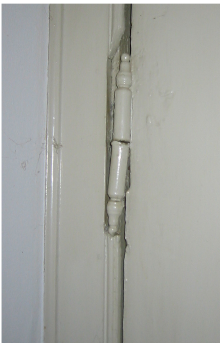
Indstukket dørhængsel også kaldt et hollandsk hængsel. Der stikkes en smal rille i hhv. dørbladet og i karmen med et særligt stemmejern, en såkaldt hængselbeitel eller lyrebeitel. Hængslets dele bankes i og sikres med to eller tre stifter.
