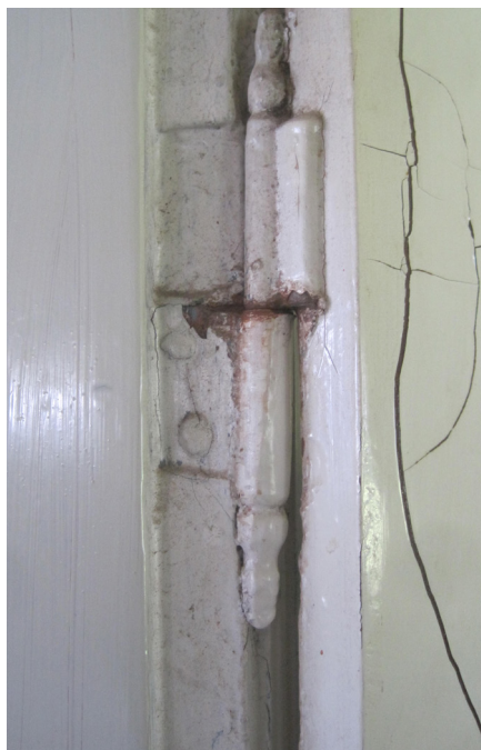
Indstukket dørhængsel også kaldt et hollandsk hængsel. Der stikkes en smal rille i hhv. dørbladet og i karmen med et særligt stemmejern, en såkaldt hængselbeitel eller lyrebeitel. Hængslets dele bankes i og sikres med to eller tre stifter.
