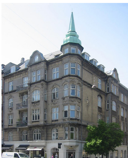
Man regner med en levetid for kobbertage på ca. 100 år, men individuelle forhold kan enten forkorte eller forlænge levetiden. Af disse to samtidigt opførte historicistiske hjørnespir, har det ene måttet skiftes ud efter de påregnede 100 år, mens det andet åbenbart kan holde lidt endnu. Kobberets iltlag, den grønne ir, der dannes efter en årrække, beskytter kobberets overflade mod tæring, bl.a. fordi irren ligger under kobber i spændingsrækken.
