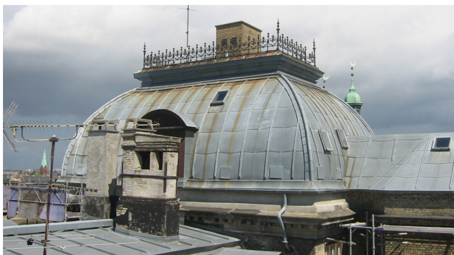
Til ruderdækning bruges kvadratiske zinkplader af varierende størrelser. Den nøjagtige størrelse kan f.eks. bestemmes ved inddeling af den aktuelle tagflade. Hver plade har to opadbøjede og to nedadbøjede fals, der griber ind i de tilstødende plader. Pladerne fastgøres med hafter, som hages til pladernes ombukning foroven og sømmes til brædderne.
