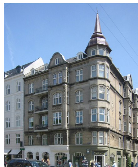
Man regner med en levetid for kobbertage på ca. 100 år, men individuelle forhold kan enten forkorte eller forlænge levetiden. Af disse to samtidigt opførte historicistiske hjørnespir, har det ene måttet skiftes ud efter de påregnede 100 år, mens det andet åbenbart kan holde lidt endnu. Kobberets iltlag, den grønne ir, der dannes efter en årrække, beskytter kobberets overflade mod tæring, bl.a. fordi irren ligger under kobber i spændingsrækken.
