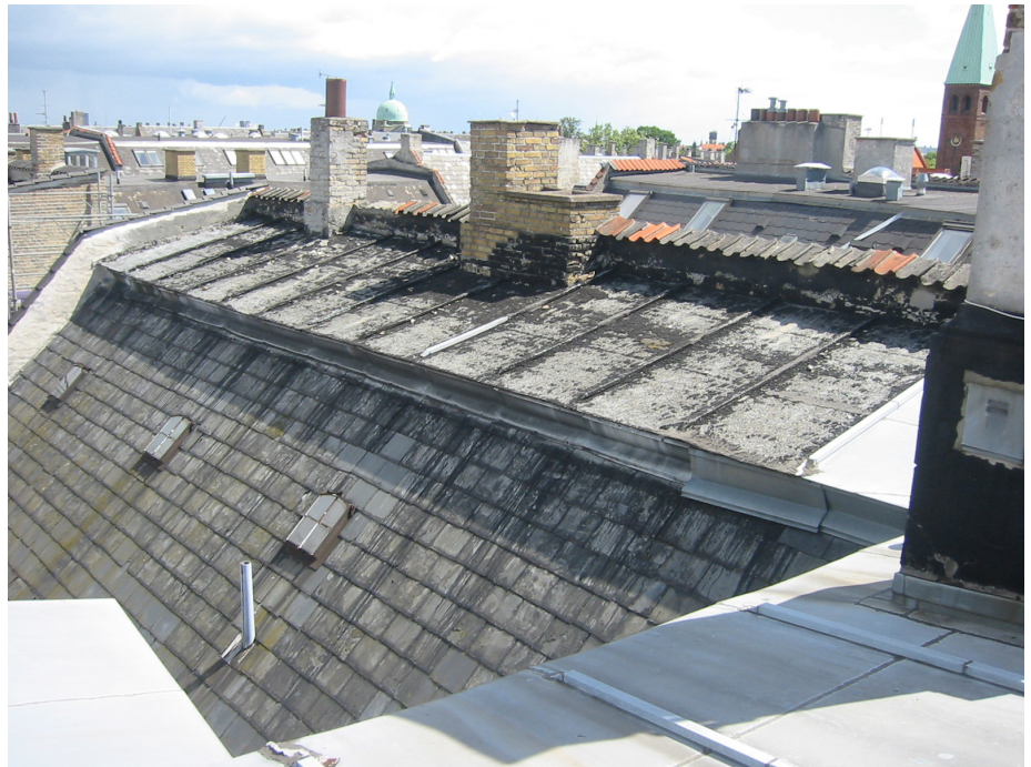
Et ægte 'københavnertag' med jernplader, der efterfølgende er behandlet med stenkulstjære
