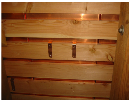
På understøtten fæstnes både langfals og her tværfals med såkaldte hafter, der bukkes med rundt i falsene. Bundet tag.
