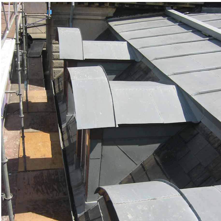
Et zinktag skal normalt skiftes efter 80-90 år, bl.a. fordi sur regn (syreregn) fra oliefyring og anden forurening tærer denne. Men da luften ikke indeholder så meget syre mere, kan man som en sidegevist ved dette forvente at zinktagene vil holde længere tid.
