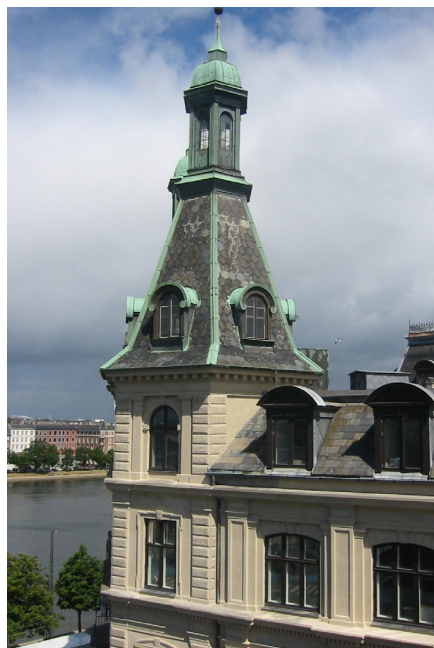
Forhåbentlig løber regnvandet fra dette kobberspir, kobberkviste og kobbergrater ikke ned gennem tagrender og nedløb af zink. Da kobber ligger over zink i den elektrokemiske spændingsrække, vil kobberionerne i nedløbsvandet angribe zinken og tære denne op på kort tid. Det omvendte kan sagtens lade sig gøre.
