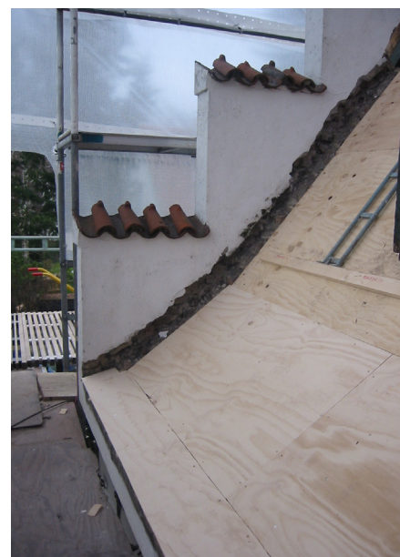
Ved oplægning af et nyt undertag, selvbærende eller fast, som her, er vigtigt at tagets opskalkning ikke forløber i et enkelt, skarpt knæk - men rundes jævnt og smukt.
