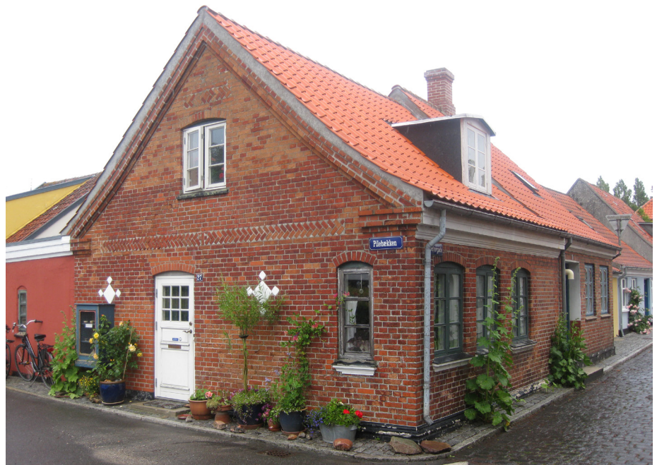
Ved oplægning af nyt tegltag med undertag 'løfter' man taget 2-5 cm. I forhold til det oprindelige udseende. Dette kan godt udføres, så tagfoden og tagrendehøjden ikke løftes, men ved gavlene vil tagets nye højde ses. En pudset gavl kan skjule dette, men ved gavle med synlige mursten kan man lægge en mursten yderligere på gesimsbåndet, eller fylde op med mørtel som her.
