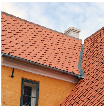
Hvis taget er forsynet med et fast undertag af brædder og pap kan man med fordel udføre skotrenderne med tegl i bunden. Det harmonerer smukt med taget i øvrigt og repræsenterer en gammel tradition.
