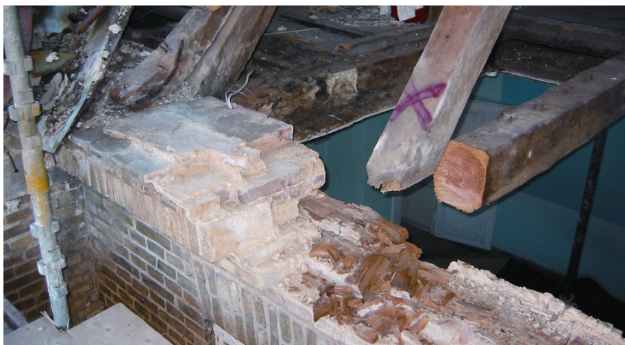
De rådne bjælke- og spænder er savet af for at gøre klar til påskarring af nye ender. Murværket er dels fjernet, hvor der var spor efter ægte hussvamp, dels varmebehandlet for eventuelle rester efter denne og herefter klar til at blive muret op igen.
