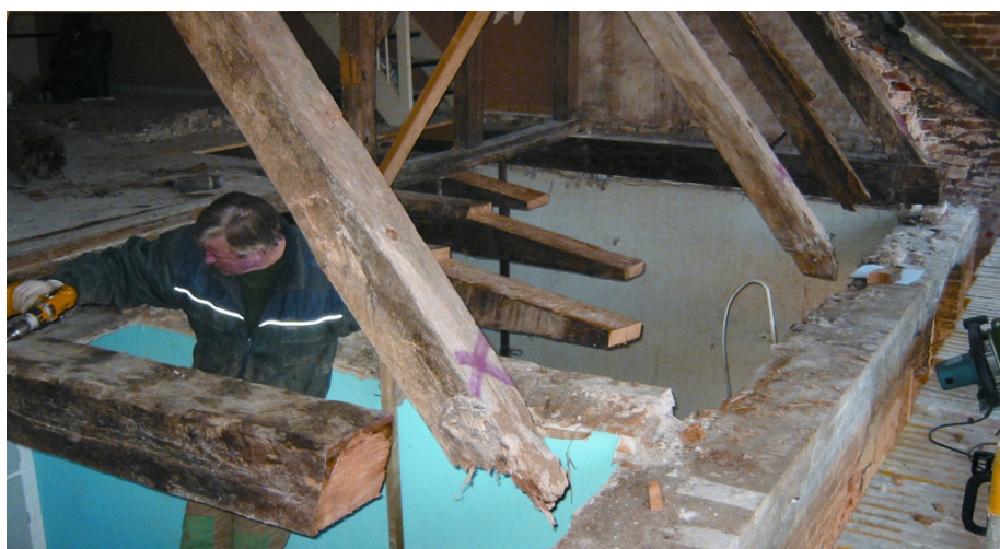
I forgrunden ses de afsavede bjælke- og spærender. Der skæres, så alt svækket og rådnet træ er bortskåret. I baggrunden ses tre bjælker, hvor der er udført den ene halvdel af et skråt hageblad. Hertil påskaarres den nye bjælkeende med en tilsvarende samling og de to dele boltes sammen.
