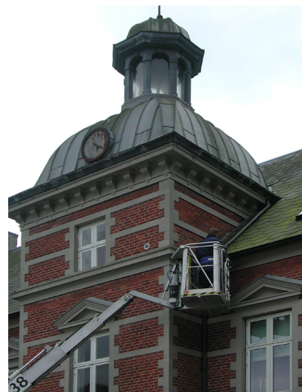
Det er en god ide at inspicere tætheden på diverse inddækninger, og tagmaterialet i det hele taget, mindst hvert 5. år gennem et grundigt bygningssyn. Her foregår det med lift, i lighed med det hollandske 'Monumentenwacht', der er et hold af uvildige eksperter med håndværksuddannelse. I Danmark findes der et lignende system siden 2000. Foto: Hans Jørgen Hansen
