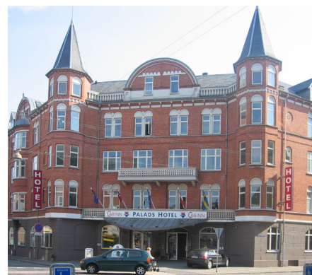
Skifer var et nyt tagmateriale i 1860-erne, men vandt hurtigt en meget stor plads i dansk bygningskultur, især i byerne. Derfor blev tårne og spir også i stort omfang beklædt med skifer.
