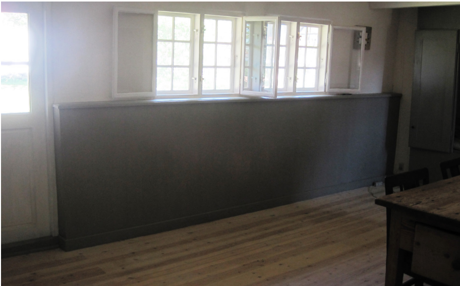
Her ses den lille 'forsatsisolering' under vindueshøjden i rummet. Den kan udføres som et malet brystningspanel og klædes ligefrem rummet. Over vinduerne er væggene fortsat uisolerede og 'tynde', hvilket gør rummet smukkere og ikke så 'smalt' som hvis isoleringen var ført til loftet. Overvæggene er her pudset med kalkmørtel og limfarvet.
