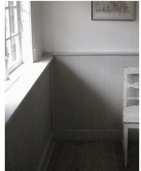
Her ses den lille 'forsatsisolering' under vindueshøjden i rummet. Den kan udføres som et malet brystningspanel og klædes ligefrem rummet. Over vinduerne er væggene fortsat uisolerede og 'tynde', hvilket gør rummet smukkere og ikke så 'smalt' som hvis isoleringen var ført til loftet. Overvæggene er her pudset med kalkmørtel og limfarvet.
