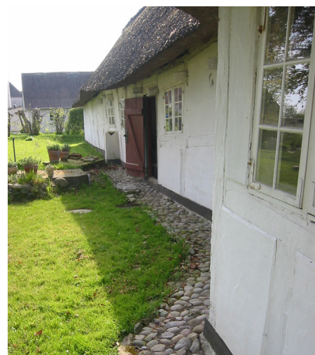
Pigstenene bevirker dels at opsprøjtet fra tagskægget "deler" sig, spredes og ændrer retning, så en mindre del af vandet rammer væggen, dels er det vand, der rammer væggen ikke bliver mudret. Hvis pigstenskanten er udført rigtigt, virker den også som en 'drænende', der leder regnvandet effektivt væk, så der ikke danner sig store vandpytter i selve tagdryppet. Rammer vanddråberne fra taget en vandpyt, sprøjter der langt mere vand op på muren, end hvis dråberne rammer en rund pigsten.
