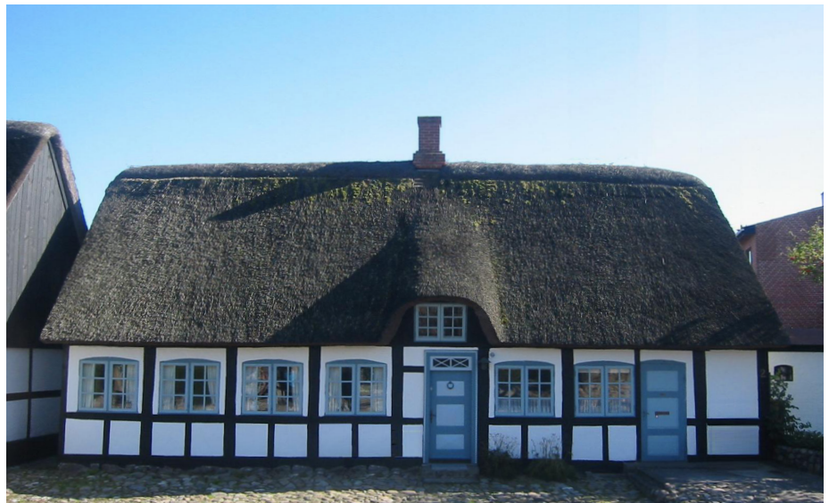
Et bindingsværkshus har, specielt i sydsiden, ofte en række helt tætsiddende vinduer i facaden. Da det vil være næsten omsonst, rent energimæssigt, at varmeisolere disse små facadestykker, anbefales det at efterisolere vinduerne med indvendige forsatsvinduer med energiglas og kun sætte max. 5 cm isolering indvendigt på stykket mellem vinduerne.
