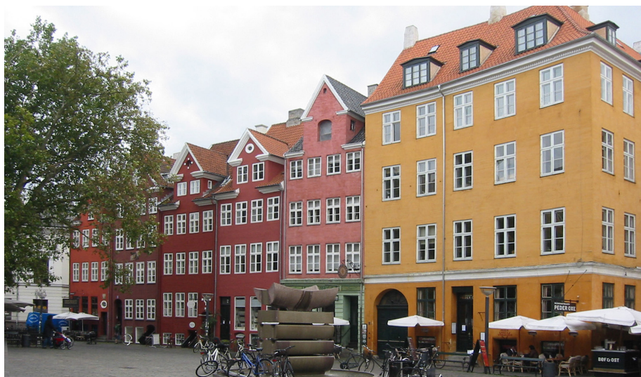
Københavnske 'ildbrandshuse', dvs. huse opført efter Københavns brand i 1728. Husene er i barokkens ånd opført som 'falske gavlhuse' med kraftige, profilerede, trukne gesimser og bånd i puds.
