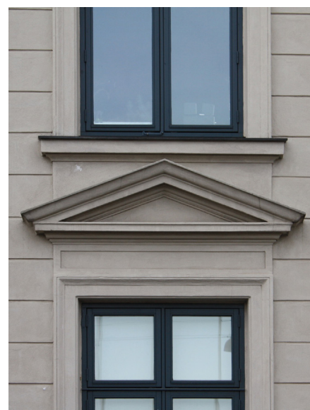
Her ses dels refendfugning (de vandrette, tilbage-liggende fuger i puds) samt en trukket trekantgavl og trukne indfatninger og sålbænke ved vinduerne. Alt sammen udført ved trækning med zinkskabeloner i den våde, udkastede mørtel.
