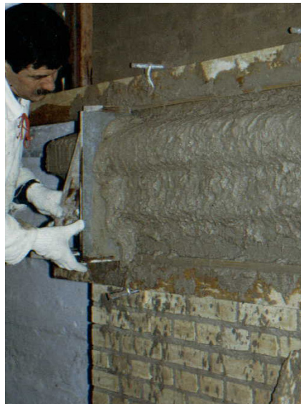
Trækning af gesimser og bånd i kalkmørtel. Zinkskabelonen er opsat vinkelret på profilen på en såkaldt slæde med et godt og solidt håndtag i. Slæden glider på en midlertidig styrelægte af træ, der er opsat på facaden. Der kastes våd mørtel på i flere omgange, og zinkskabelonen skraber den overskydende mørtel af, så profilen til sidst står ren og skarp. Foto: Arne Høi
