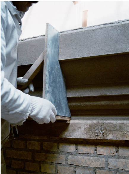
Trækning af gesimser og bånd i kalkmørtel. Zinkskabelonen er opsat vinkelret på profilen på en såkaldt slæde med et godt og solidt håndtag i. Slæden glider på en midlertidig styrelægte af træ, der er opsat på facaden. Der kastes våd mørtel på i flere omgange, og zinkskabelonen skraber den overskydende mørtel af, så profilen til sidst står ren og skarp. Foto: Arne Høi
