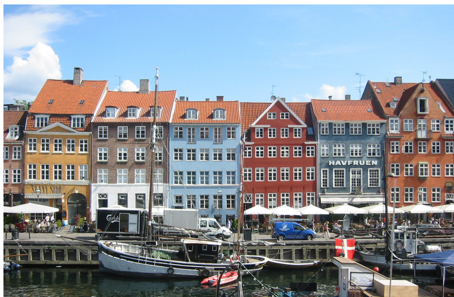
Gesimser er fortrinsvis vandrette, men på gavltrekanter føres gesimsprofilen op langs de skrå gavlafslutninger. Gesimser behøver heller ikke at sidde lige under tagudhænget. Kordongesimsen er et vandret, profilet 'bånd', der afslutter underfacaden. Profilerede lister, der sættes rundt om døre og vinduer, kaldes ikke for gesimser, men benævnes indfatninger, evt. trukne indfatninger, for at skille disse fra indfatninger udført af andre materialer.
