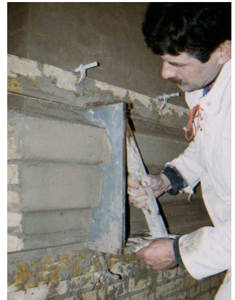
Trækning af gesimser og bånd i kalkmørtel. Zinkskabelonen er opsat vinkelret på profilen på en såkaldt slæde med et godt og solidt håndtag i. Slæden glider på en midlertidig styrelægte af træ, der er opsat på facaden. Der kastes våd mørtel på i flere omgange, og zinkskabelonen skraber den overskydende mørtel af, så profilen til sidst står ren og skarp. Foto: Arne Høi
