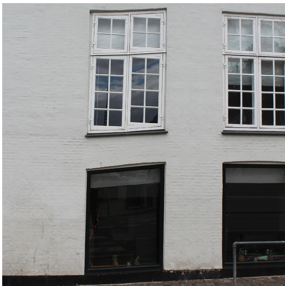
Sætningsskadet byejendom. Fundamentsvigt har givet skæve vinduer. Foto: Anne Lindegaard
