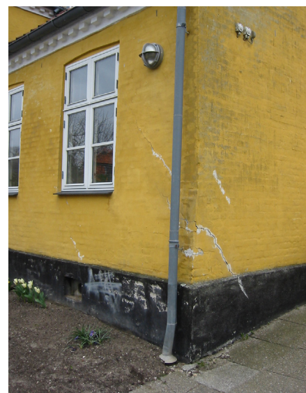
Her er diagnosen ret klar, hushjørnet synker, hvorved revnerne åbner sig ned mod hjørnet. I andre tilfælde kan det være sværere at se, hvor problemerne er, men udgangspunktet er revnernes 'retning' – hvor de åbner sig, og hvor de er lukkede.
