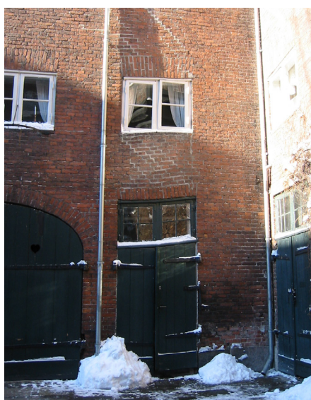
Svigtende fundering under facaden mens gavlen ikke er sunket.
