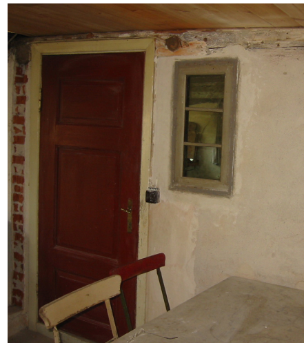
Er bindingsværket synligt, vil man kunne se dørøverligeren eller spor efter denne i form af naglehuller. Står murværket synligt, kan false eller nye stenformater afsløre det gamle dørhul – eller her, vindueshul.
