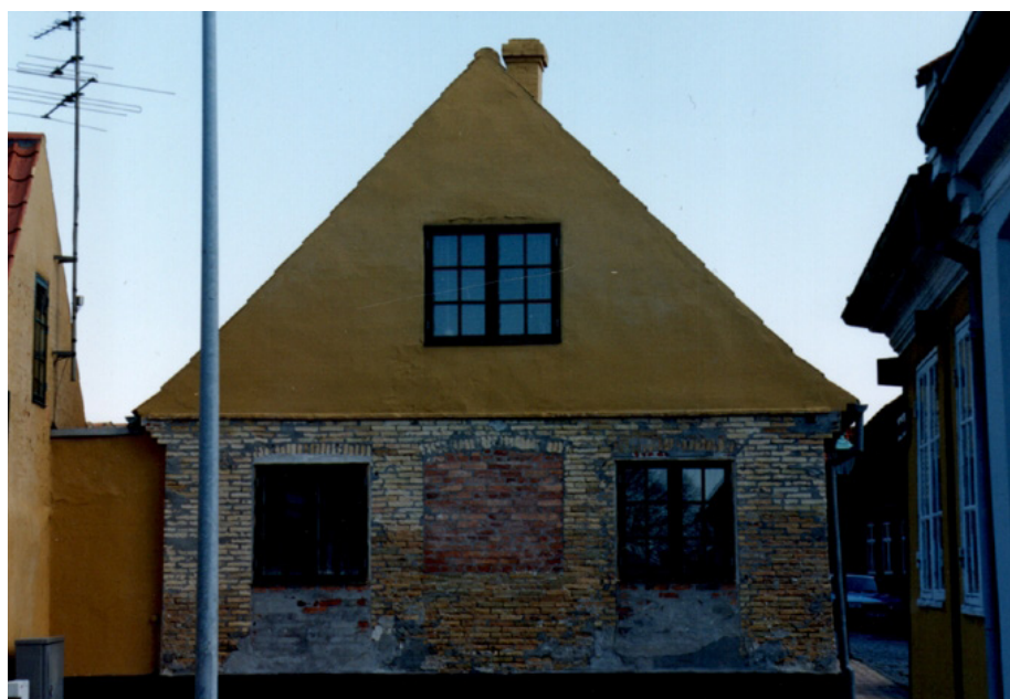
Afhugget puds afslører et tilmuret, ældre vindue i gavl
