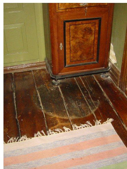
Spor i gulvet efter en tidligere kakkelovnsplacering
