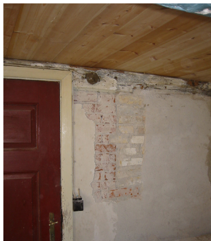
Er bindingsværket synligt, vil man kunne se dørøverligeren eller spor efter denne i form af naglehuller. Står murværket synligt, kan false eller nye stenformater afsløre det gamle dørhul – eller her, vindueshul.
