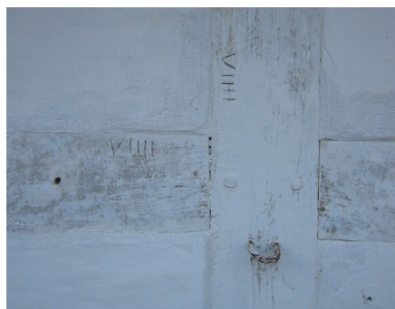
Bindingsværksnummerering foregår næsten altid med romertal som vist her, men da XI og IX kan forveksles, set på hovedet, benyttes altid kun plus-streger, aldrig minus-streger; så i det tilfælde skrives VIII i stedet for IX.
