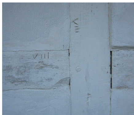
Tømmermærker på bindingsværk. Ved hjælp af disse kunne man tildanne tømmeret del for del på en "afbindingsplads", og senere samle det på fundamentene. Ved hjælp af tømmermærkerne kunne man også flytte bindingsværkshuset, som det bl.a. skete under landboreformerne i 1790-erne m.v.
