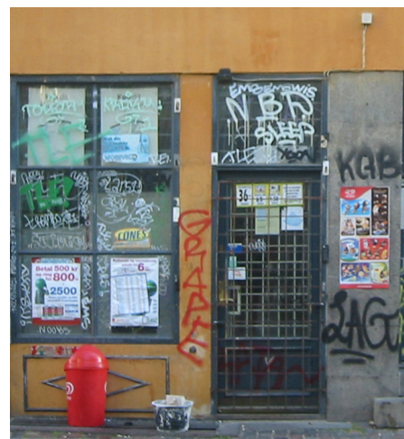
Tyverisikring er én ting – her et pressegitter på butiksdøren, men 'hærværkssikring' – her i form af graffiti, er en anden sag. Et pænt udseende er faktisk en vigtig del af selve sikringen af butikken. Derfor skal man straks fjerne graffiti og løbende holde udseendet ved lige.
