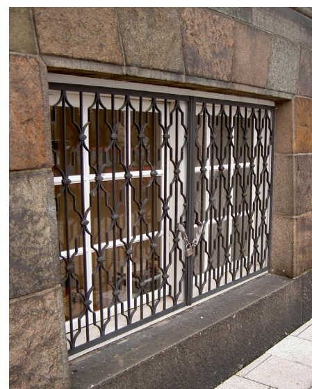
Smedejernsgitter til sikring af kældervindue
