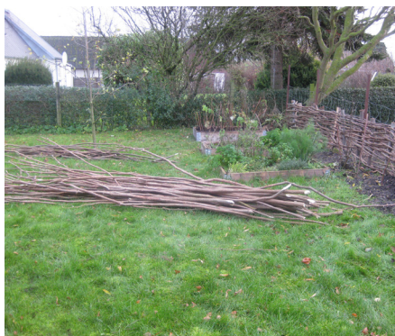
Risgærde under bygning. De fingertykke hasselkæppe ligger klar til fletning.
