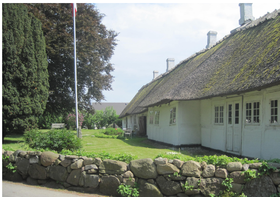
De største sten sættes forned, og ca. 1/3 af disse sten skal være under jordoverfladen. Derved får stengærdet det mest stabile fundament. De mindste sten sættes i midten og de mellemstore øverst, således at overkanten bliver vandret, tung og fast. En omhyggelig udvælgelse af stenene inden opsætningen gør det lettere at passe de rigtige sten sammen. De skal indbyrdes støtte hinanden og kiles ind imellem hverandre, således at de ikke kan flyttes eller skubbes. Foto: Anne Lindegaard
