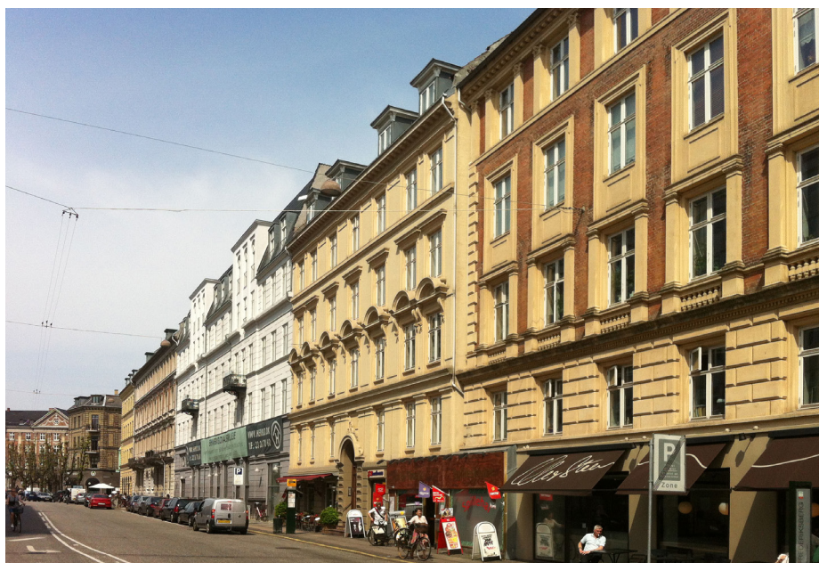
Udvendig facadeisolering er rent teknisk en god løsning for murede huse, men hvis der forekommer facadedekorationer og kraftigt relief i facadearkitekturen, der er så typisk for ældre bygninger, eksempelvis fra historicismen som her, er dette umuligt. Man kan så i stedet isolere tagrummet, mod terræn og sætte forsatsvinduer på vinduerne. Hvis brystningerne under vinduerne er meget tynde og kun i én stens murværk, kan man også efterisolere indvendigt her.
