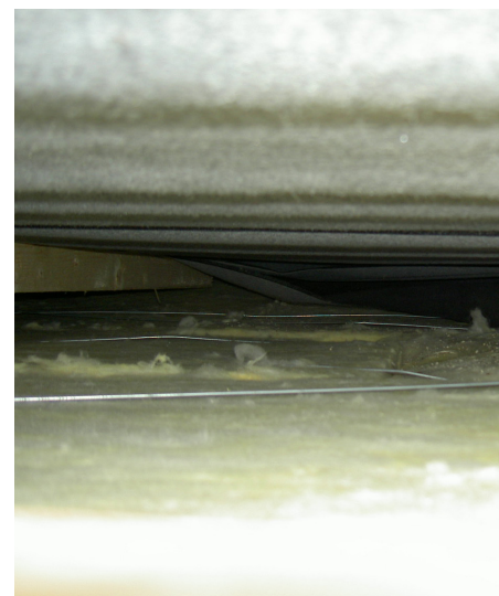
Efterisolering af et tagrum mellem spærene. Der opsættes en diffusionsåbent, selvbærende undertag oven på spærene med lægter og tagsten over. Herunder isoleres der med mineraluld, men andre isoleringsmaterialer i batts kan også bruges, f.eks. hør, cellulosefibre, papir. Det er vigtigt, at der etableres et fastholdt, ventileret hulrum på 3-5 cm (billedet t.h.) mellem isolering og undertag. Her sidder der ståltråde, der forhindrer isoleringen i at lukke hulrummet.
