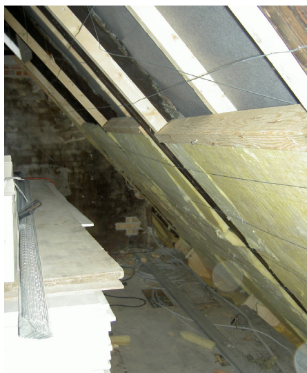
Efterisolering af et tagrum mellem spærene. Der opsættes en diffusionsåbent, selvbærende undertag oven på spærene med lægter og tagsten over. Herunder isoleres der med mineraluld, men andre isoleringsmaterialer i batts kan også bruges, f.eks. hør, cellulosefibre, papir. Det er vigtigt, at der etableres et fastholdt, ventileret hulrum på 3-5 cm (billedet t.h.) mellem isolering og undertag. Her sidder der ståltråde, der forhindrer isoleringen i at lukke hulrummet.
