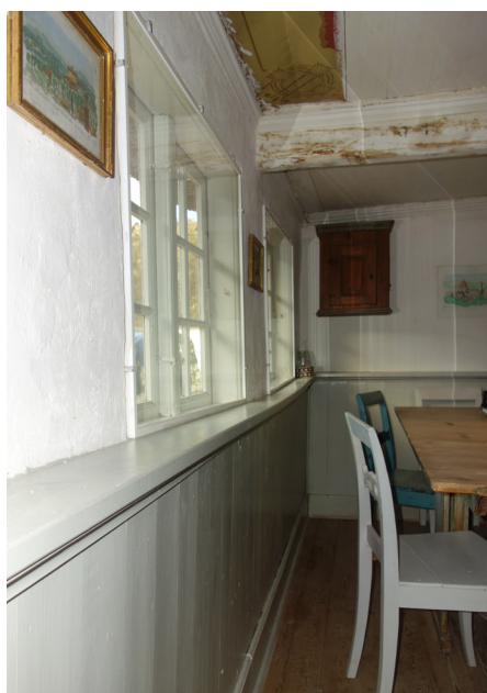
Indvendig forsatsvæg under vindueshøjde på et bindingsværkshus. Over brystningshøjde og mellem vinduerne efterisoleres der ikke, da disse vægstykker dels er så små og fordi det visuelt ikke formindsker rummet.
