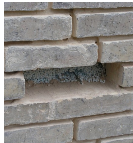
Ved hulmursisolering fræser man mursten ud på strategiske steder, så hulmuren kan blive fyldt med et isoleringsmateriale – granulat eller luftfyldte kugler. Dette blæses ind, hvorefter hullerne lukkes med de samme mursten. Man kan evt. efter dette udtage andre sten, for at kontrollere, at hulmuren er fyldt op, som den skal.
