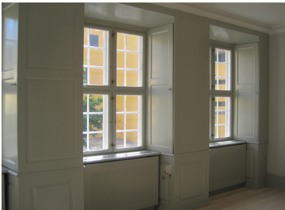
Rent bort set fra de arkitektoniske og bevaringsmæssige omkostninger, vil de økonomiske omkostninger ved at etablere en indvendig efterisolering af denne ydervæg, incl. flytning af paneler, loftsstuk m.v., være så store, at arbejderne ikke vil være rentable. Ikke mindst set i forhold til den ret lille isoleringsmæssige effekt, der kan opnås.
