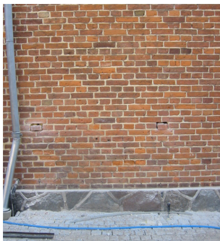
Ved hulmursisolering fræser man mursten ud på strategiske steder, så hulmuren kan blive fyldt med et isoleringsmateriale – granulat eller luftfyldte kugler. Dette blæses ind, hvorefter hullerne lukkes med de samme mursten. Man kan evt. efter dette udtage andre sten, for at kontrollere, at hulmuren er fyldt op, som den skal.
