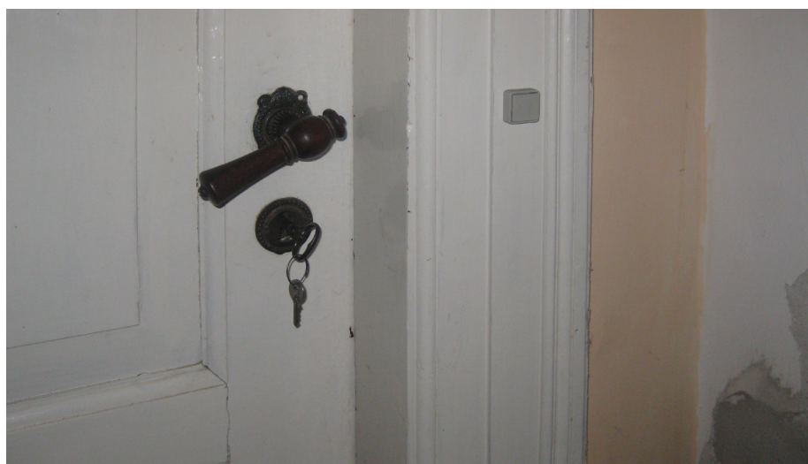
Svagstrømsafbryder, anbragt midt på dørindfatningen, hvor den i kraft af sin lidenhed synes meget lidt.
