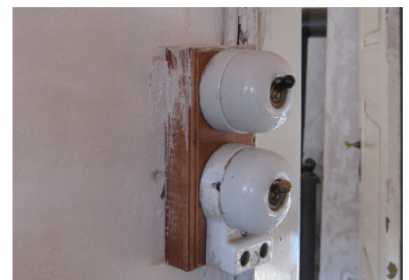
Hvis de gamle originale afbrydere og stikkontakter af porcelæn og messing, eller rent porcelæn, fra begyndelsen af 1900-tallet, sidder i huset endnu, kan man få disse sikkerhedsundersøgt i forbindelse med trækning af nye kabler, hvorefter de eventuelt kan genbruges. Alternativt produceres der en moderne afbryder af messing, der ligner de gamle lidt, men ikke så flotte og spændstige som disse i designet.
