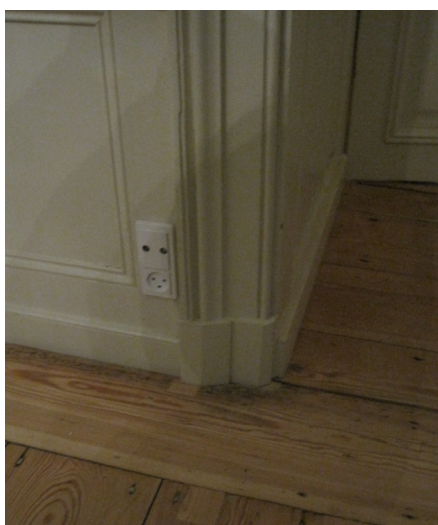
Stikkontakter kan med fordel anbringes 5 cm over fodpanelet, hvor de næsten ikke ses.
