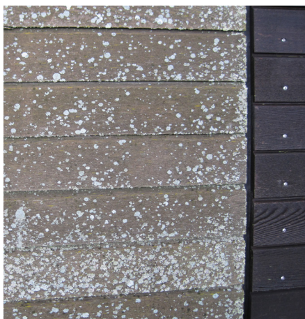
Algevekst (gråfarve-svampe) på overfladen af en træbeklædning er forholdsvis uskadelig for træet, men er et tegn på, at miljøet er for vådt. Foto: Arne Høi
