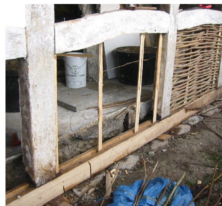
Fodremmen er typisk det der rådner først på en bindingsværkskonstruktion. Er man heldig, er stolpeenderne intakte, som her.
