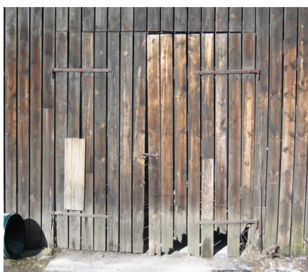
Svamp og råd er i princippet det samme. Begge nedbrydningsformer er angreb af en eller flere svampearter. Når man i praksis skelner mellem svamp og råd, skyldes det et forsikringsteknisk forhold, hvor svamp er det pludselige, hurtigt udviklede angreb, mens råd er betegnelsen for et angreb med en langsom udvikling, der kan strække sig over 10-15 år eller mere.
