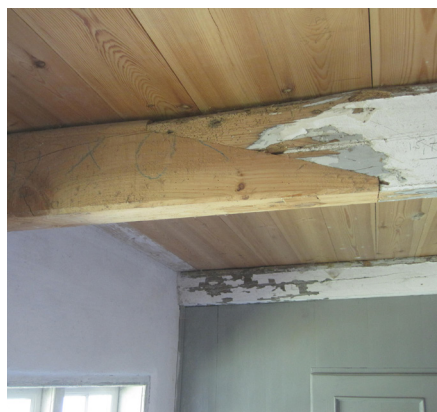
Bjælker repareret efter svampeangreb
