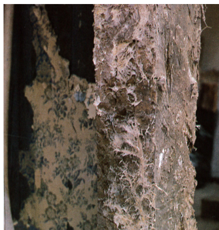
Ægte hussvamp er meget farlig for alt træ, da den er stærkt nedbrydende og bl.a. selv kan fugte træet op, så nedbrydningen går endnu hurtigere.
