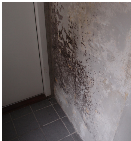
Skimmel på kold og fugtig kældervæg.
