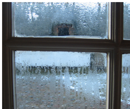
Den udvendige besigtigelse skal også påpege misfarvninger, men her er nedbrydning af især puds og mørtel ofte dominerende, bl.a. i form af saltudblomstringer. Afskallet maling kan også være tegn på fugtighed i ydervæggen. Udvendigt træværk efterses for begyndende svampeangreb. Både inde og ude bør luftens fugtighed og temperatur måles, og f.eks. væggenes fugtindhold registreres.
