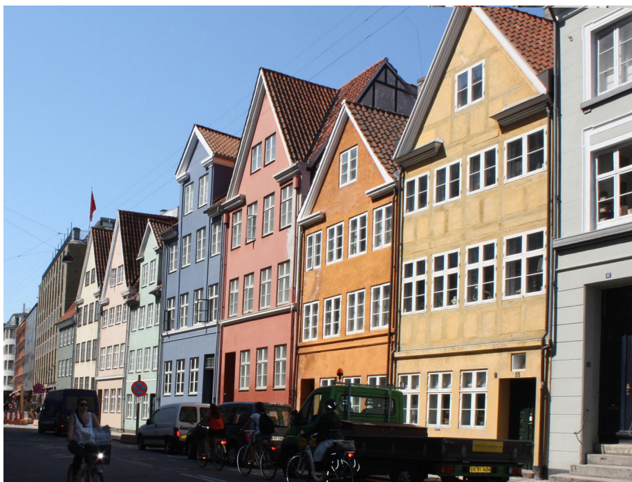
Typisk etagehusbyggeri 'indenfor voldene' i København, de såkaldte 'Ildebrandshuse'. Disse adskiller sig arkitektonisk og byggeteknisk en del fra 'Brokvarterernes' etagehuse fra 1850-1890.
