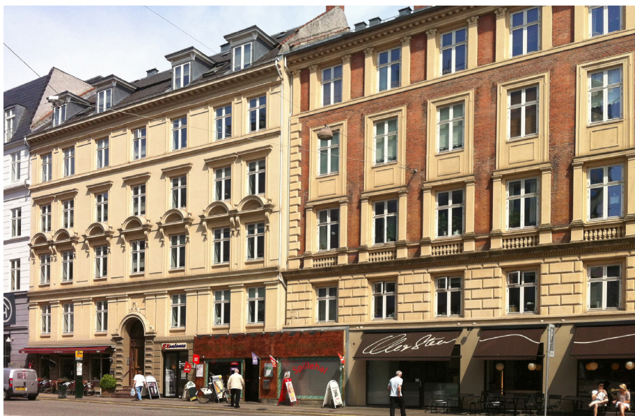
Typiske etagehuse, her på Frederiksberg. Den øvre del af facaden fremtræder ofte som blank mur inddelt vandret med kordonbånd. Fugerne i murværket er efterbehandlet, så de er glatte og ofte udført skrå eller med en profil. Overfacaden kan dog også være pudset – igen med vandrette bånd for at fremhæve 'mellemfacaden'. Underfacaden får synsmæssig tyngde ved refendfugning eller kvaderpuds.
