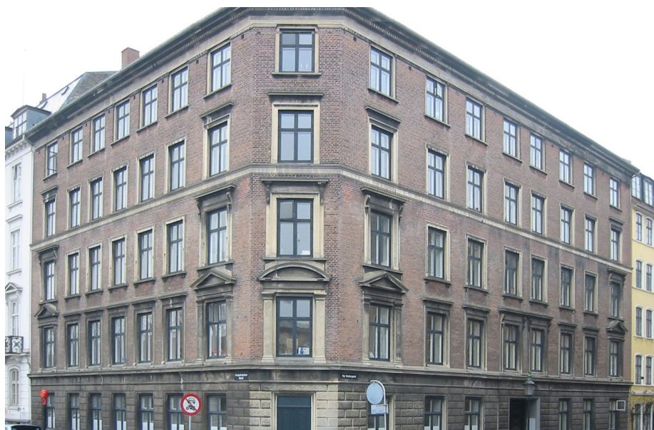
Typiske etagehuse opført på det i 1856-1901 frigivne 'voldterræn' foran Københavns Volde, der tidligere ikke måtte bebygges af forsvarsmæssige grunde. Området fik nu navnene Nørrebro, Vesterbro, Sønderbro og Østerbro, og bærer derfor samlet navnet 'Brokvartererne'.
