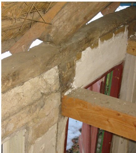
Styrtrumskonstruktion med gennemstukne bjælketappe med to udvendige tværnagler.
