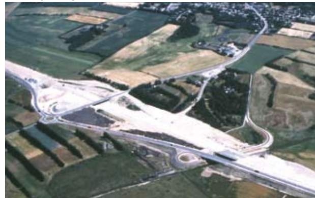
Motorvejsanlæg ved Varbro Å, 1995
