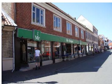
Hus der er fornyet uden hensyn til husets oprindelige opbygning
