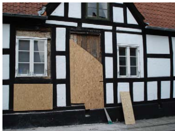
Bindingsværkstavl under reparation
