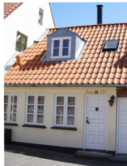
Metalskorsten placeret bag rygningen
