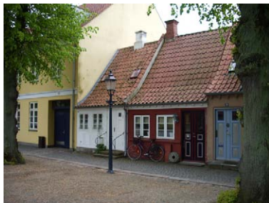
Fint udførte skorstene
