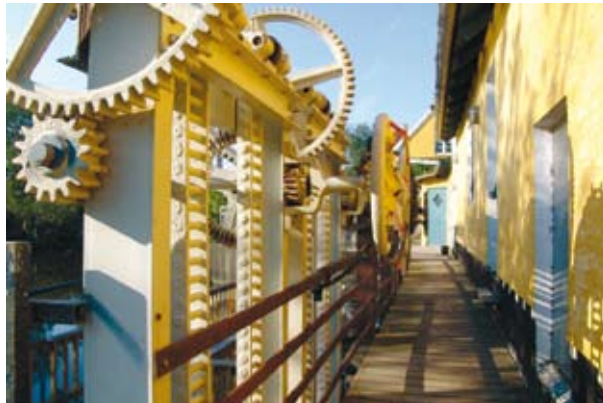
Gangbro over stemmeverket på Bindslev Gl. Elværk
