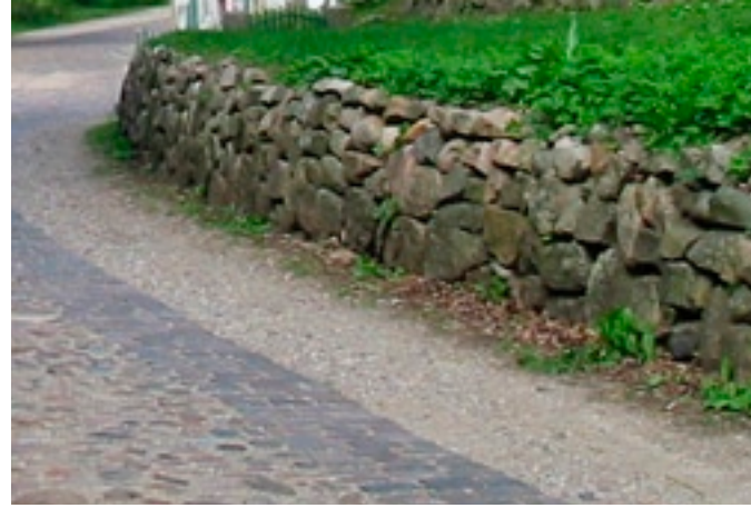
Stensætning og slidstærk belægning
