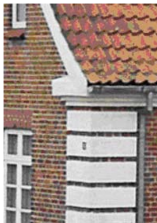
Arkitektens "varemærke" er rødstensbygninger med hvidkalkede gesimser og kvadrerede hjørnelisener.
