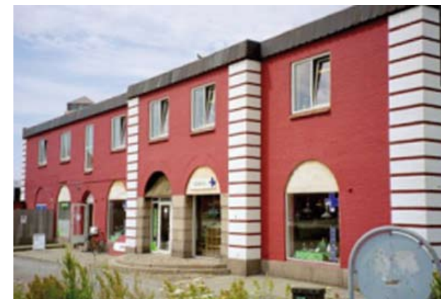
Hjørring Vestbanegård i 2003. I 1973 brænder tagetagen. Siden har bygningen været en skygge af sig selv uden tagetage. Der er planer om sanering af området og renovering af bygningen.
