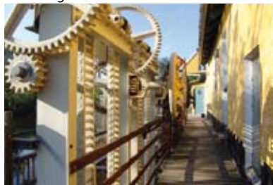
Gangbroen over stemmевærket - Bindslev gamle elværk
