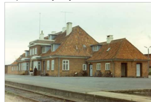
Den nye station blev taget i brug 1. december 1939
